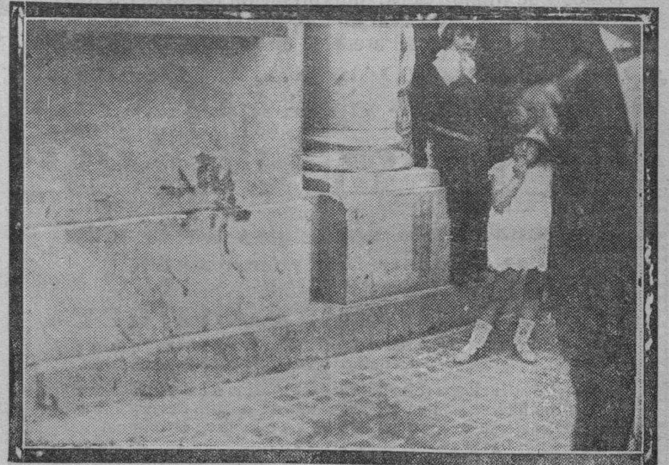
Las huellas que han quedado en la fachada del Banco de Aragón. Puede verse claramente la mancha de sangre de una de las víctimas.
