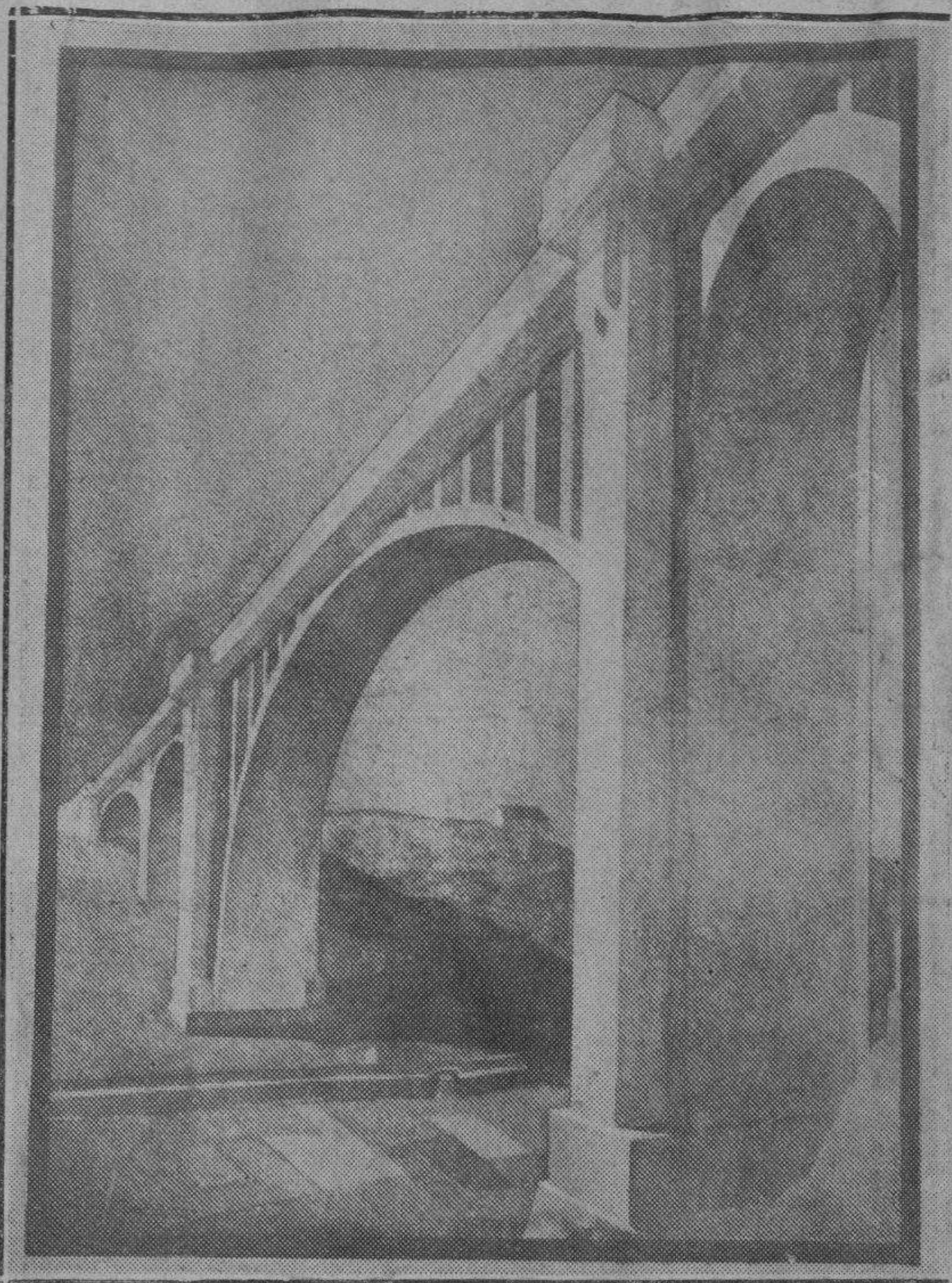
Notable viaducto, próximo a inaugurarse.—Es el primero en orden de importancia en España y el tercero en Europa (Proyecto del ingeniero don Fernando Hué) (Dibujo de Emilio Perals)
