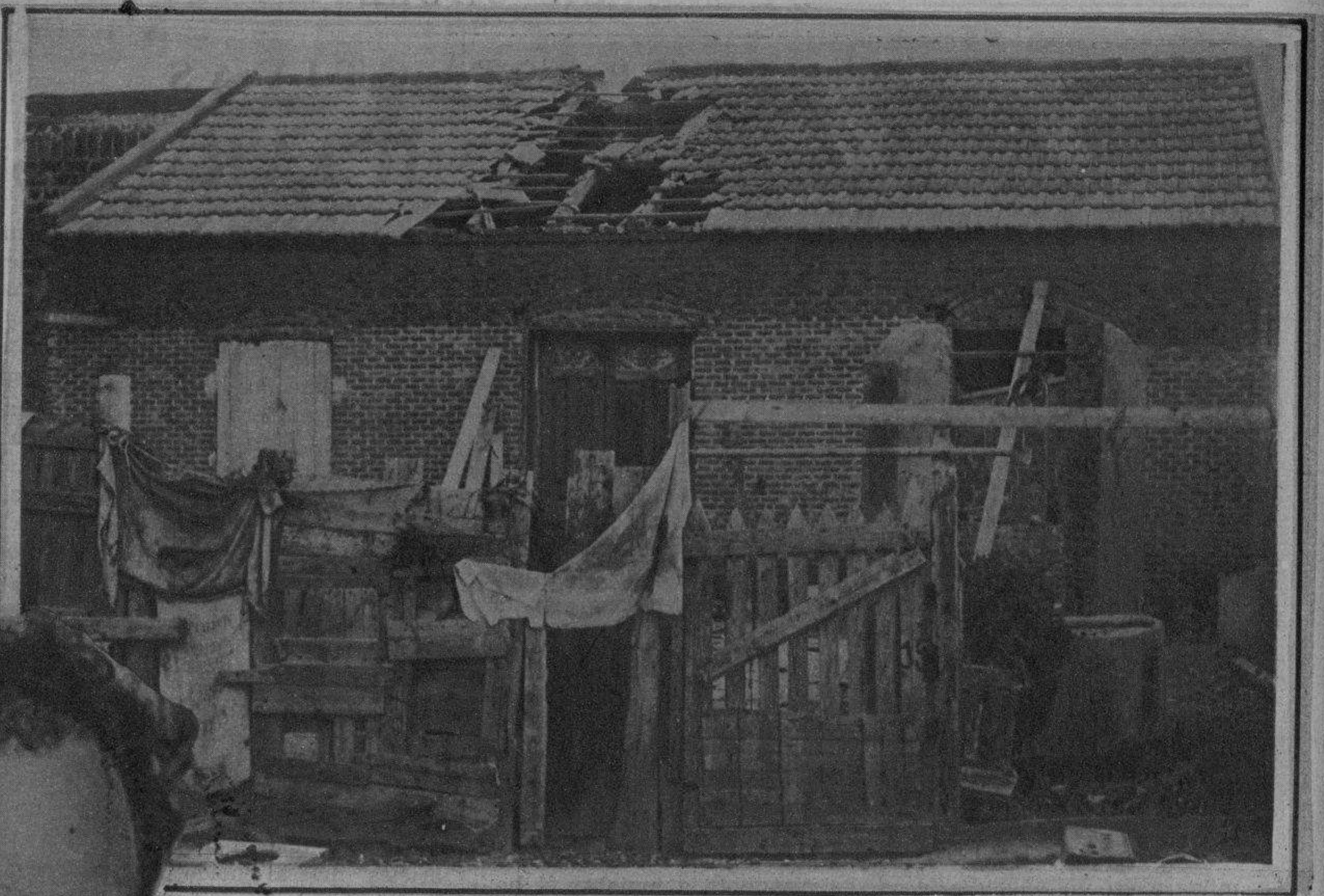
Una mísera vivienda de las inmediaciones del Aeródromo, a la que la artillería gubernamental ocasionó graves daños.—(Fots. Archivo de LA CALLE)
