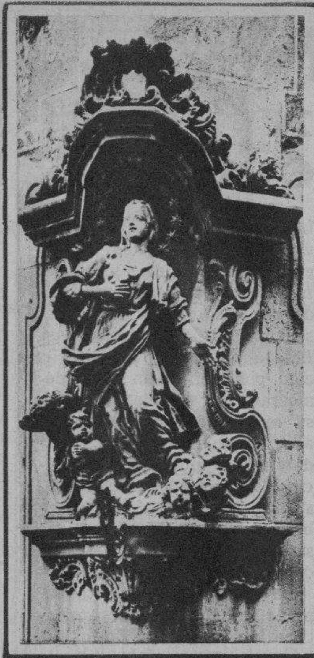
Detalle de la fachada
