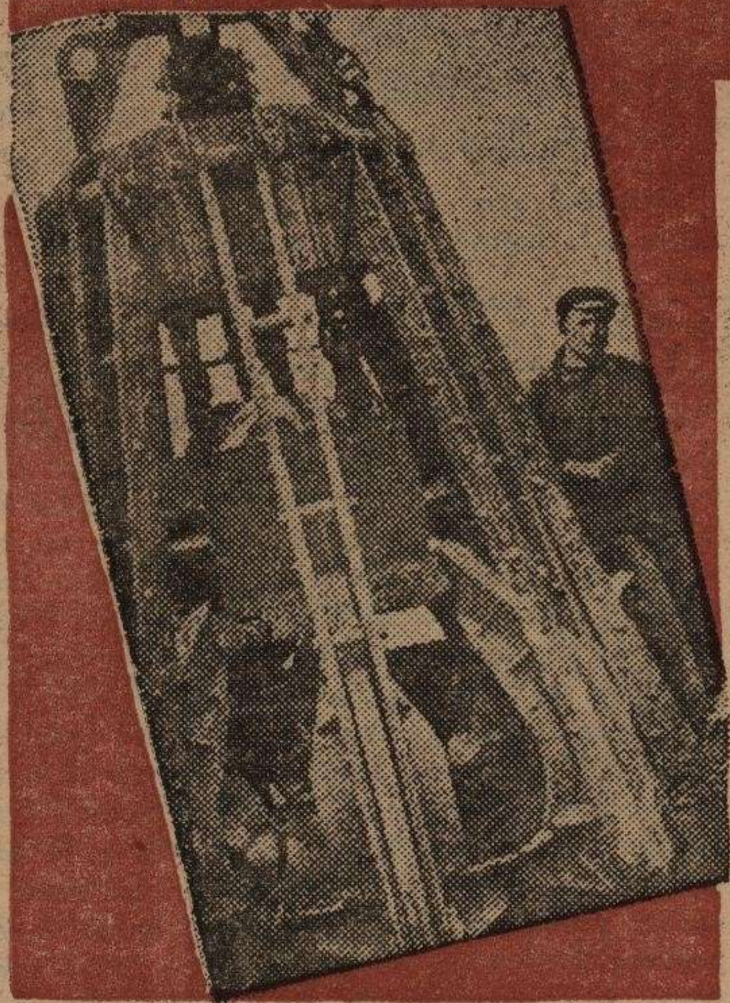
ARRIBA: Un puesto telefónico, mientras se realiza la inmersión.—La torre de acero que sirvió para los trabajos de buceo.
