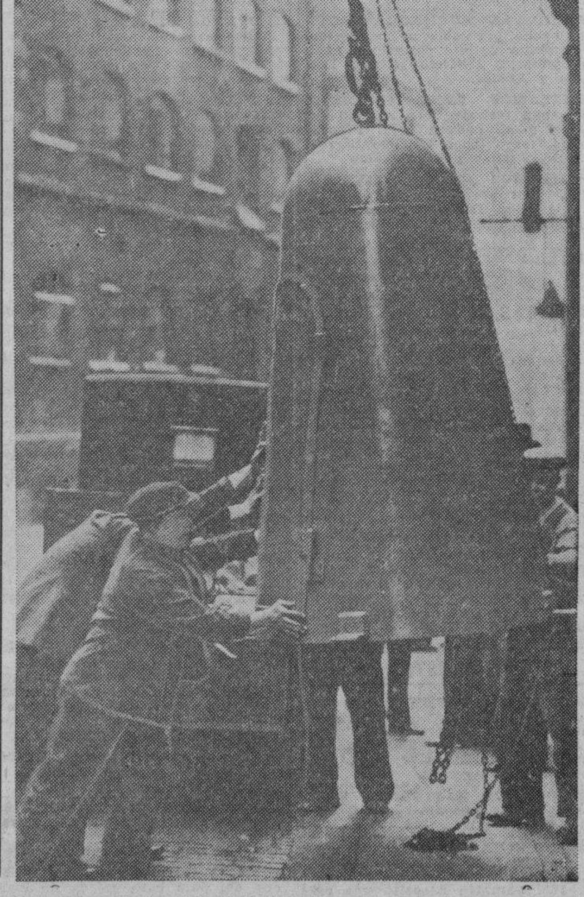
Este refugio portable, a prueba de bombas, está siendo subido al tejado de una casa de Fleet St., centro del periodismo de Londres, para permitir a los observadores localizar los lugares donde caigan las bombas incendiarias, en el caso de un ataque aéreo.—(Foto Acme-Editors Press).
