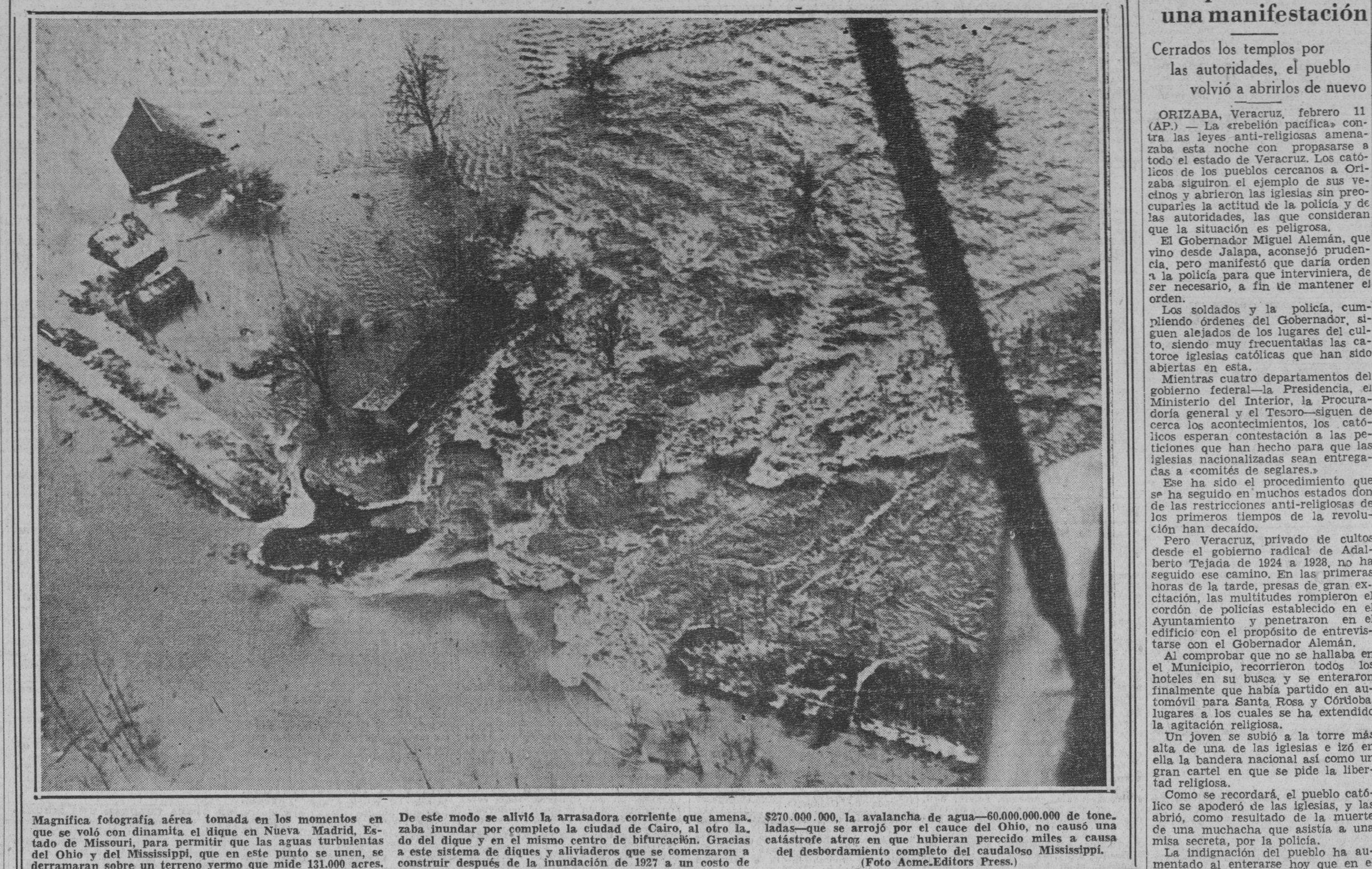
Magnífica fotografía aérea tomada en los momentos en que se voló con dinamita el dique en Nueva Madrid, Estado de Missouri, para permitir que las aguas turbulentas del Ohio y del Mississippi, que en este punto se unen, se derramaran sobre un terreno yermo que mide 131,000 acres.
