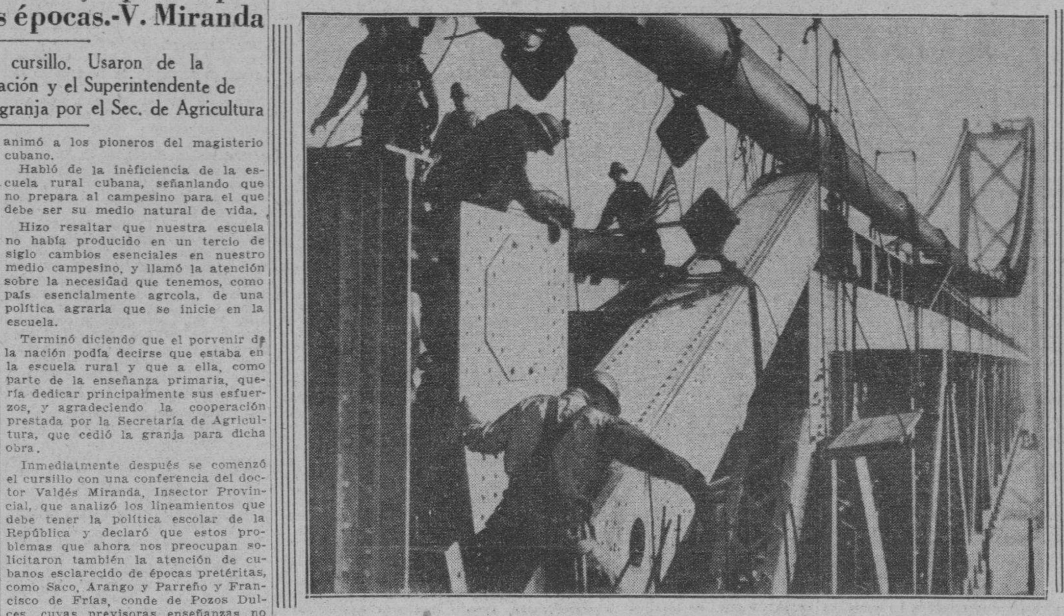
La construcción del puente gigante de San Francisco a la bahía de Oakland, fué completada cuando los obrecolocaron en su lugar la última plancha de acero. Solamente resta aún por emplazar en el citado puente el piso que corresponde a los muelles dobles del mismo.
