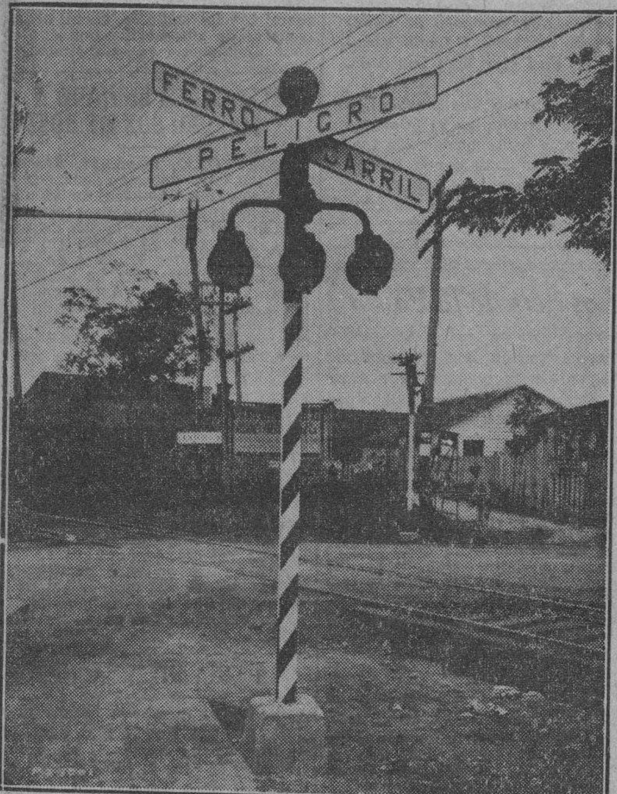
Fotografía de una de las nuevas señales que emplean los Ferrocarriles Unidos en los pasos a nivel
