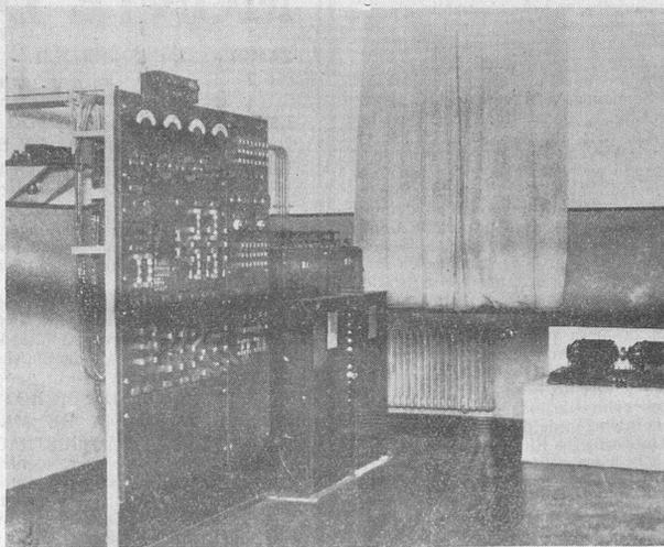
Muy pocas palabras podremos escribir para la descripción del equipo de batería de acumuladores, rectificadores de válvula de mercurio, panel de maniobra, con sus correspondientes volantes, conmutadores, amperímetros, voltímetros, etcétera, para la carga y descarga de las baterías que abastecen las necesidades de ambas centrales.
