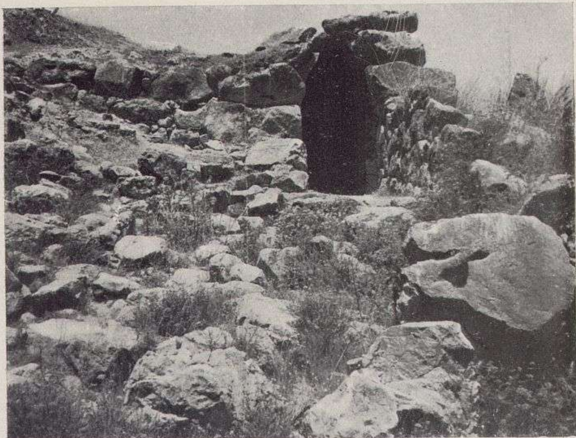
Fig. 1.—Detalle del corredor con casamatas en la muralla de Tirinto (Grecia).
