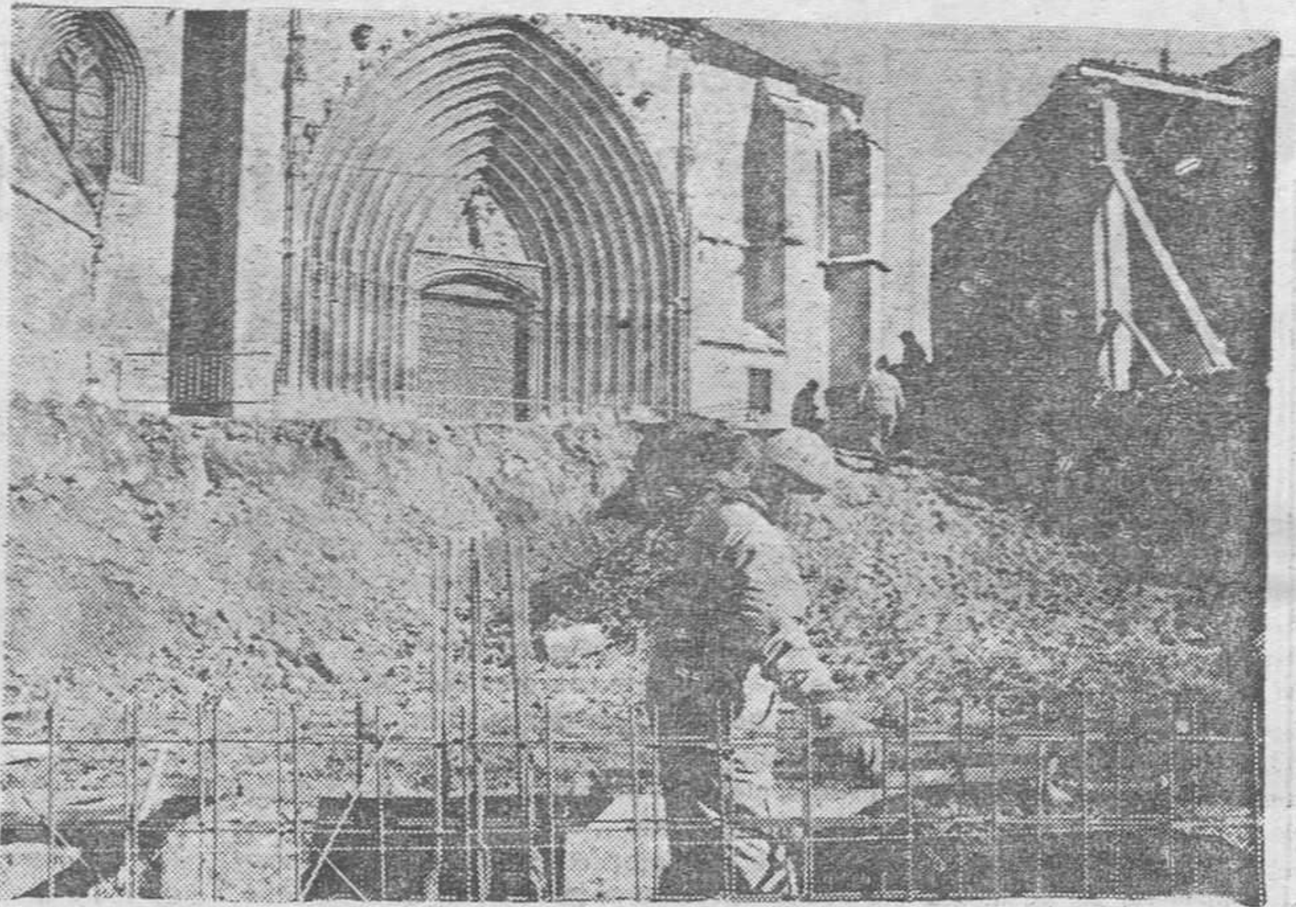
Las obras de la Casa de las Bolas ya han comenzado y van a buen ritmo de trabajo.
