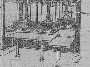
Lijadoras de cilindros, platos cinta; taladradoras corrientes y de cadena; prensas de chapar, encoladoras; maquinaria completa para serrierías, carpinterías y fábricas de muebles. Instalaciones modernas con exhaustores y colectores de polvo y viruta. Máquina universal, con tupi vertical, tipo único, práctico, resultado extraordinario. Pascual Climent, calle Alicante, 23, 25 y 27, Valencia.
