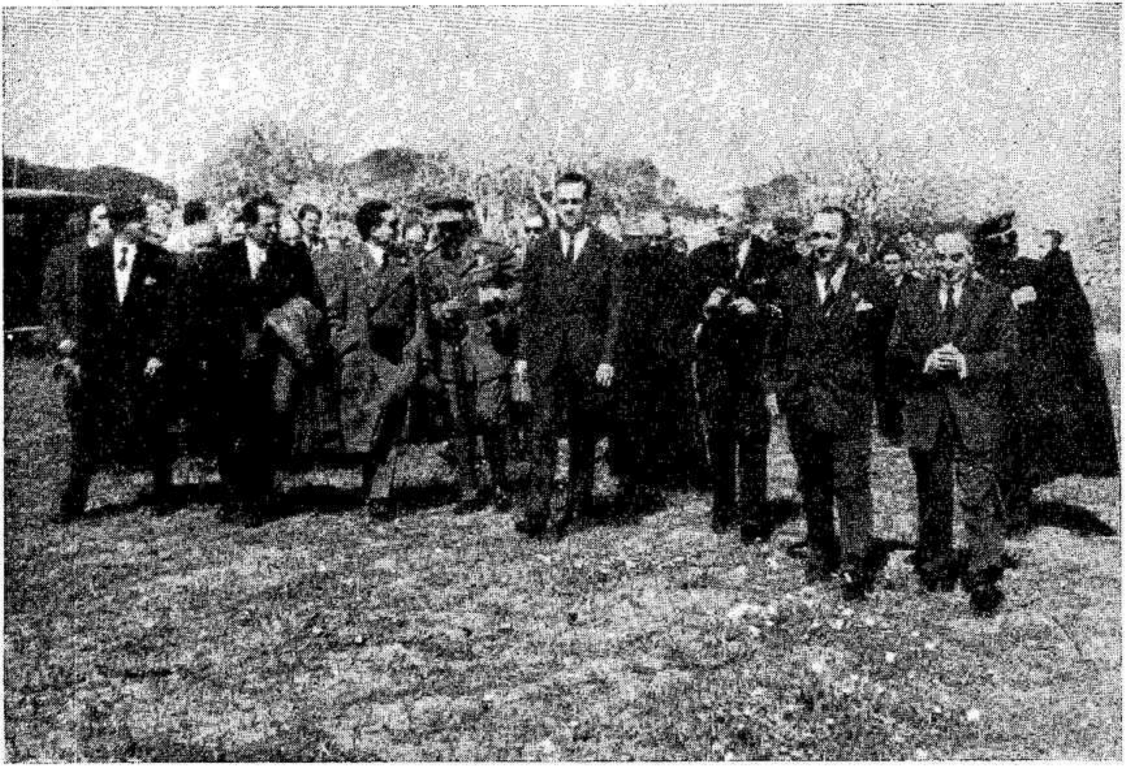
VISITANDO LOS TERRENOS DONDE SE EDIFICARÁ EL NUEVO EDIFICIO DEL INSTITUTO DE ENSEÑANZA MEDIA.
