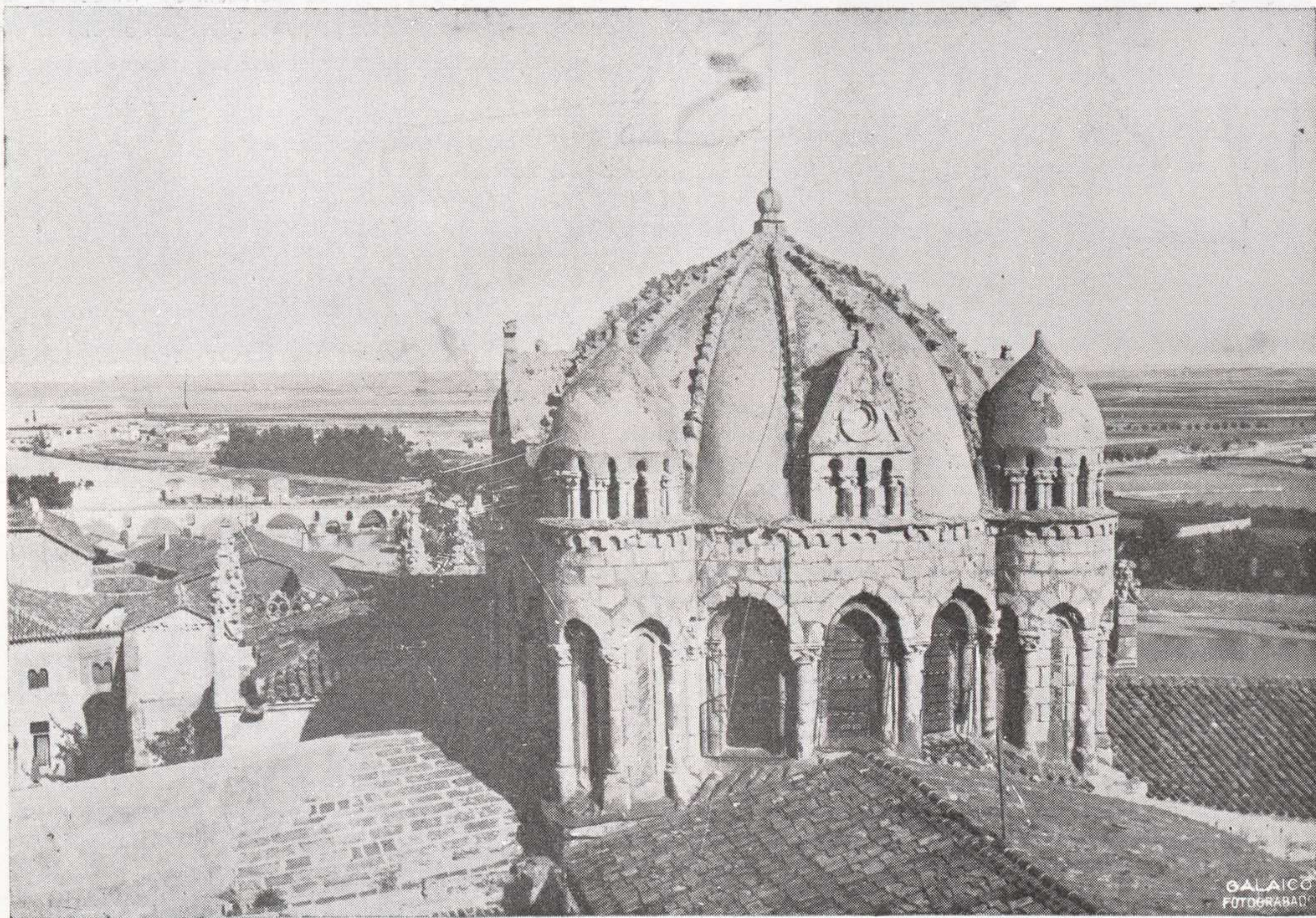
Cúpula de la Catedral antes de su restauración
