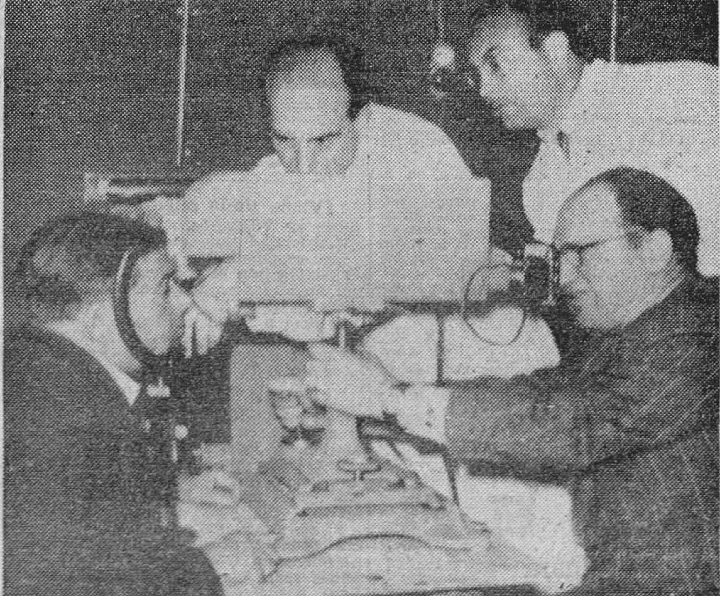
BARCELONA.—Don Cristóbal Garrigosa, inventor del moderno retinógrafo que aparece en la foto, en presencia de varios especialistas realiza las primeras pruebas del aparato que por un interesante procedimiento de iluminación permite obtener fotografías en color del fondo del ojo. El aparato, que es el primero que se fabrica en el mundo, puede aportar un notable avance en la ciencia oftalmológica.—(Foto Cifra Gráfica.)
