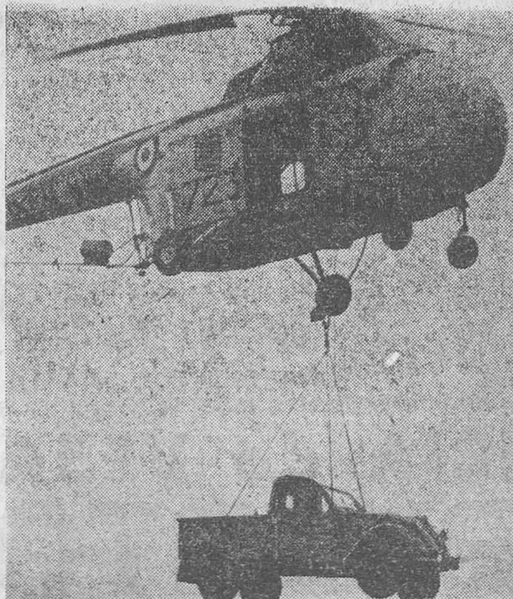
En la fotografía de la izquierda se ve cómo ayuda la Marina británica al Ejército transportando sus vehículos por helicóptero durante las operaciones anfibas efectuadas recientemente en la costa meridional de Inglaterra. Y en la fotografía de la derecha se aprecia la utilidad del helicóptero al instalar sobre una torre de veinticinco metros y medio, sin emplear ninguna grúa, una baliza de aproximación que pesa media tonelada, en el nuevo aeropuerto de Gatwick, al sur de Londres
