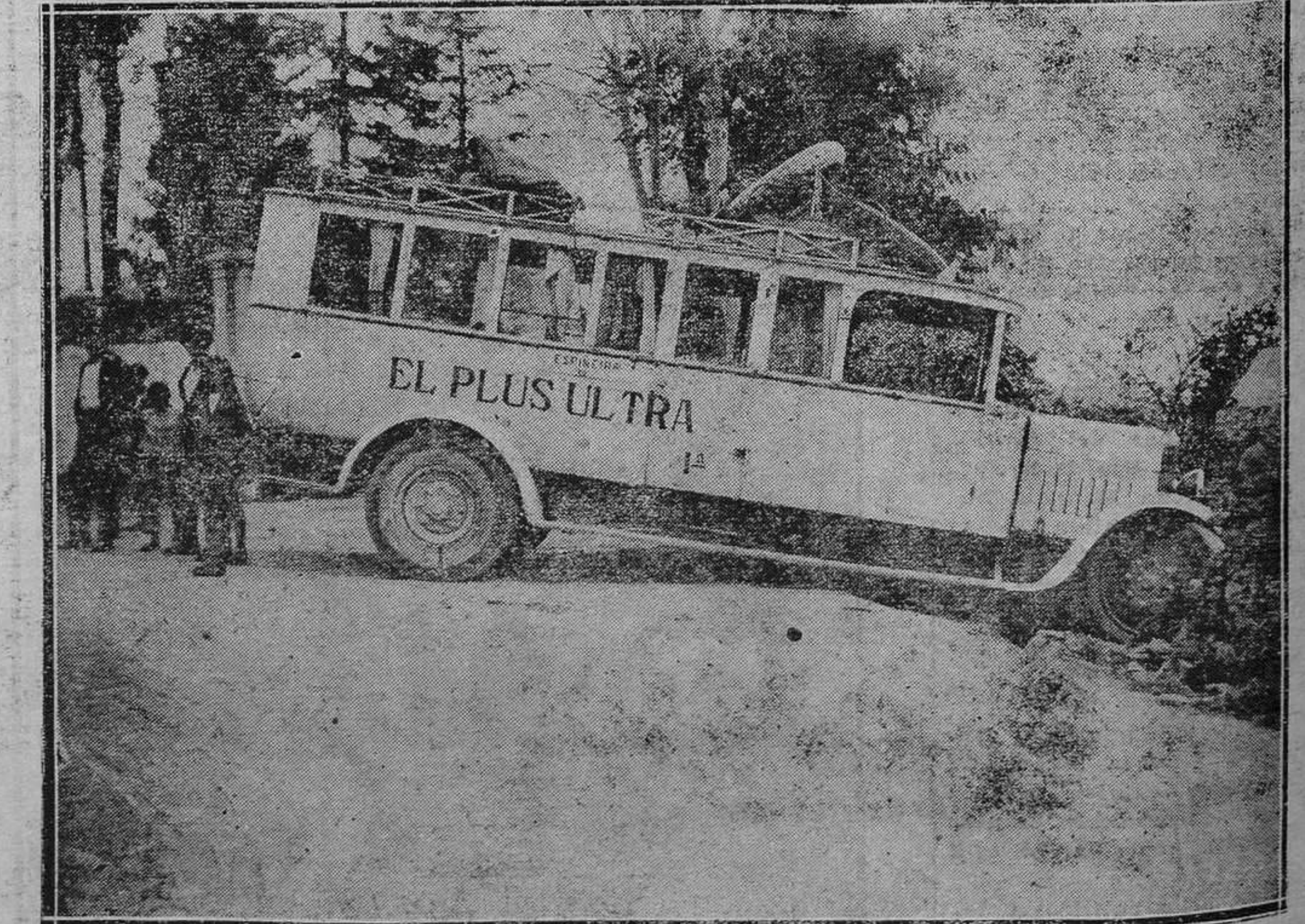
En la carretera de Sograndio, un auto de línea, al tomar una curva, por efecto de una falsa maniobra se empujó contra el paredón del Reformatorio, en el que abrió una gran brecha (Foto Mena).
