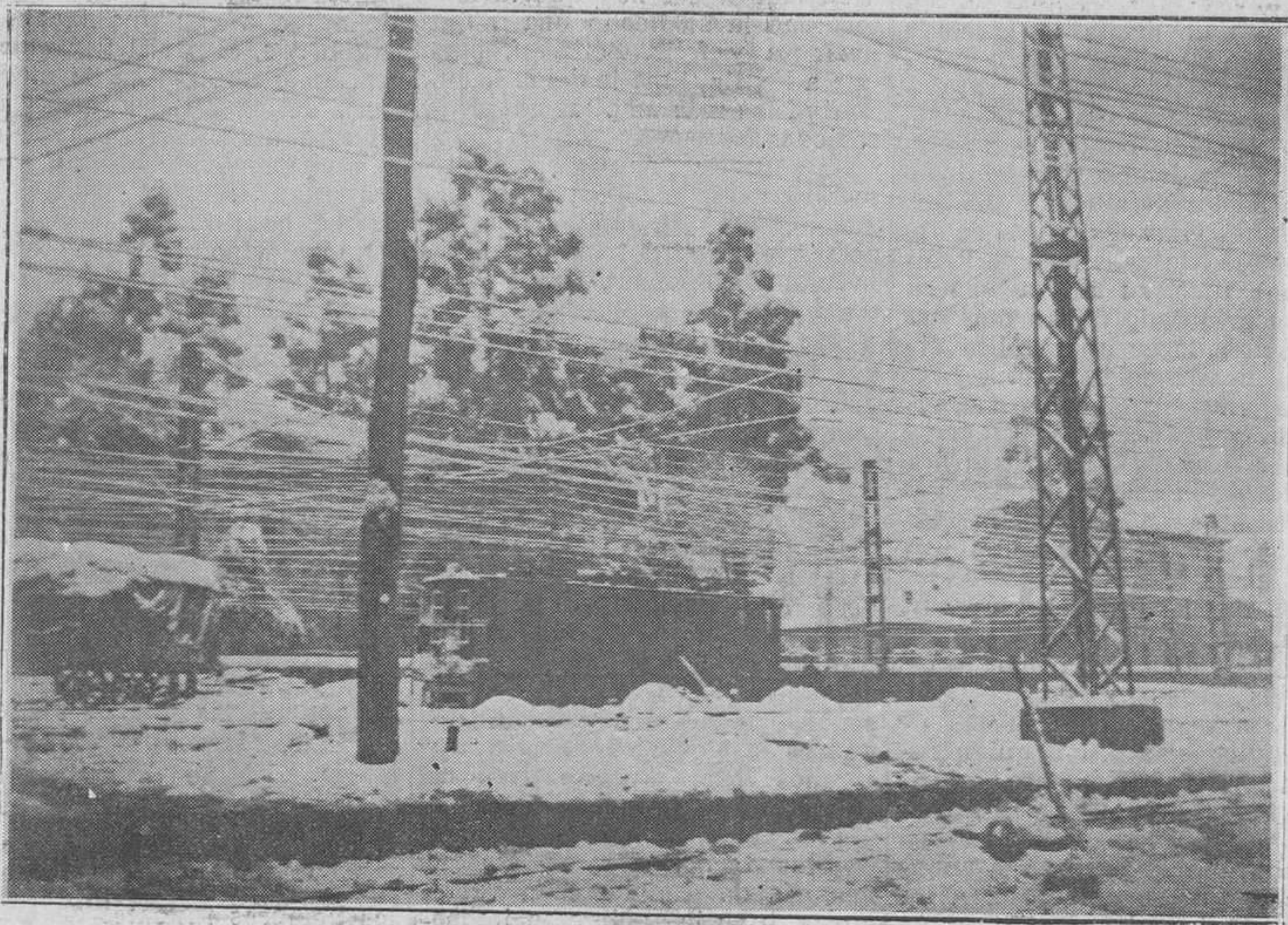
UJO: LA NEVADA.-Vista parcial de la estación del Norte.
