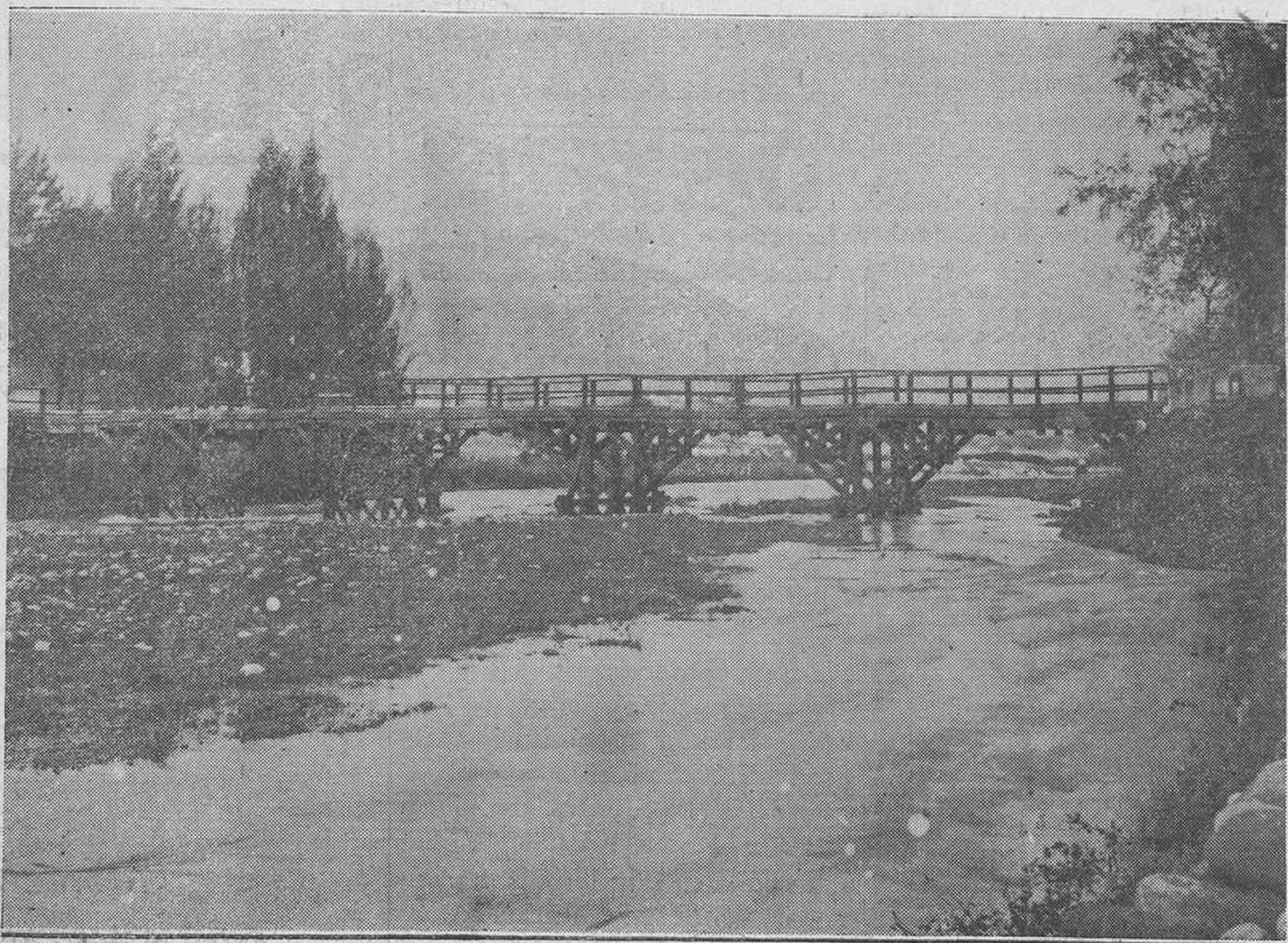
GRADO.-Puente de La Mata
