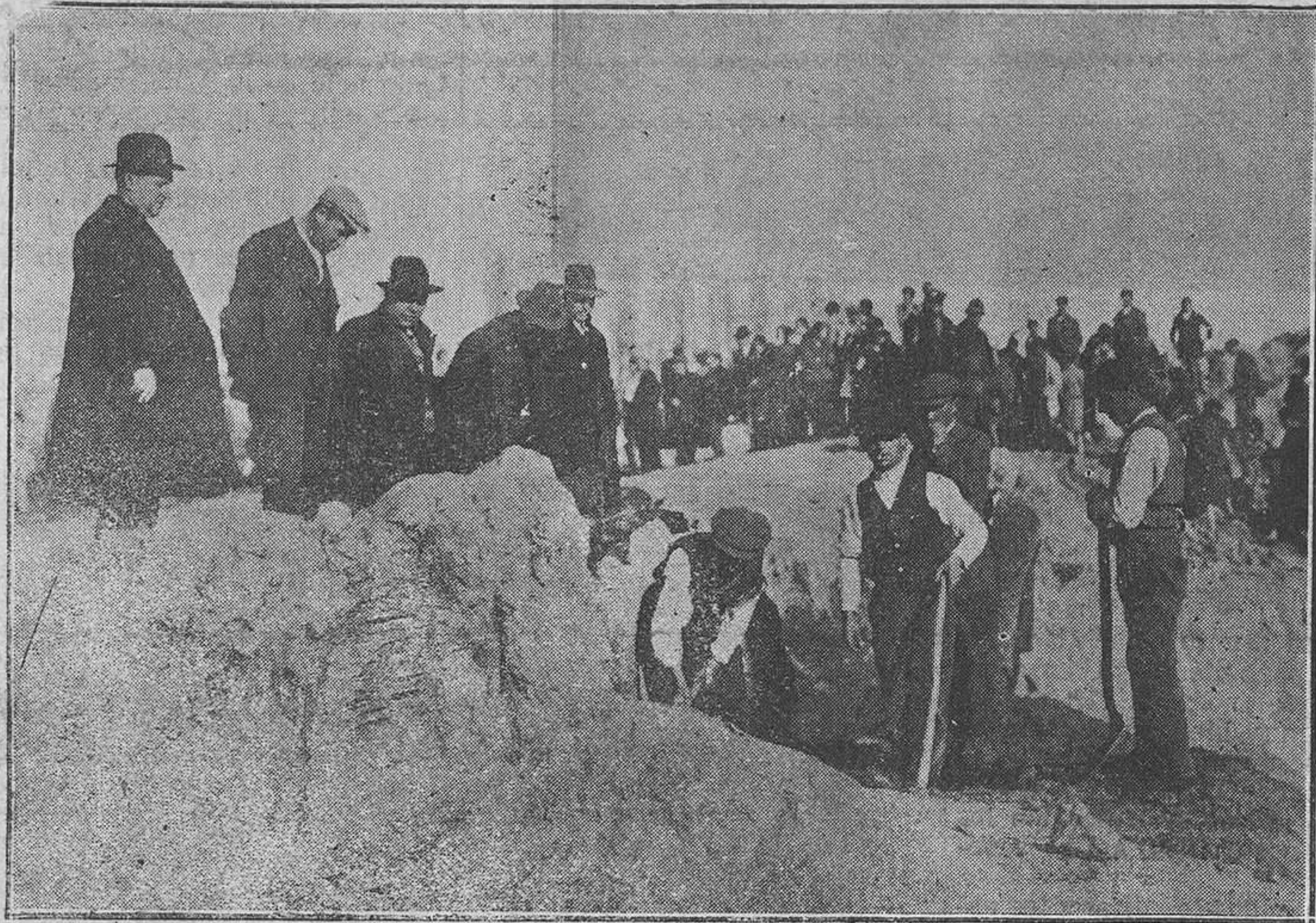
Madrid.-El Comisario del distrito de la Universidad, señor Ro'dán, y los agentes a sus órdenes, presenciando en los desmontes de la calle de Cea Bermúdez, esquina a Hilarión Eslava, las excavaciones que han dado por resultado el hallazgo de los restos de las niñas desaparecidas hace cuatro años. (Foto Vidal)
