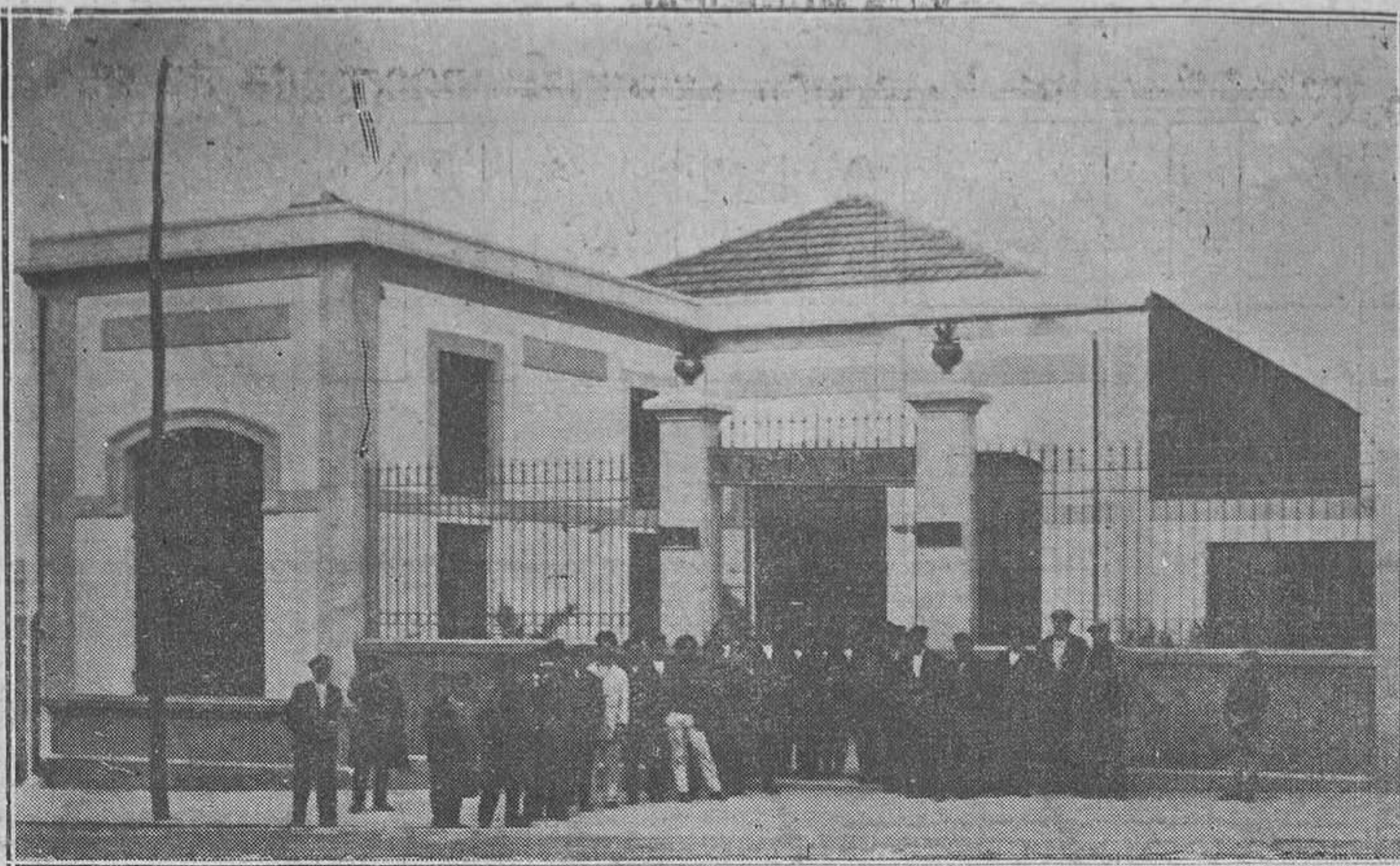
Oviedo.-Entrada principal del magnífico edificio que ocupa "Vetusta" en la calle de Gerbanes. (Foto Mena)
