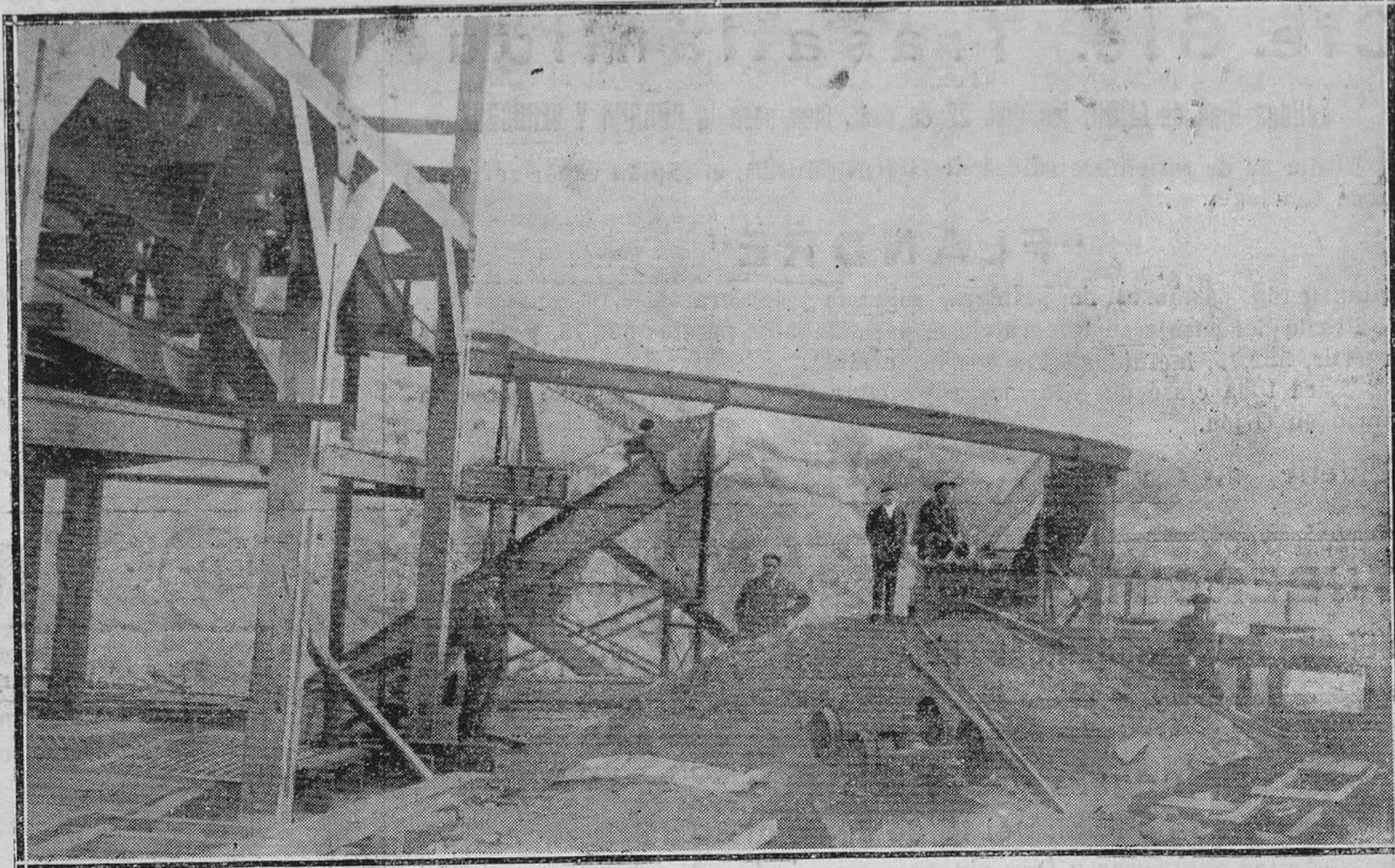
COMO SE TRABAJA EN ASTURIAS.--Las minas.--Clasificación de los productos lavados y transportador de los mismos, en una mina de Moreda.
