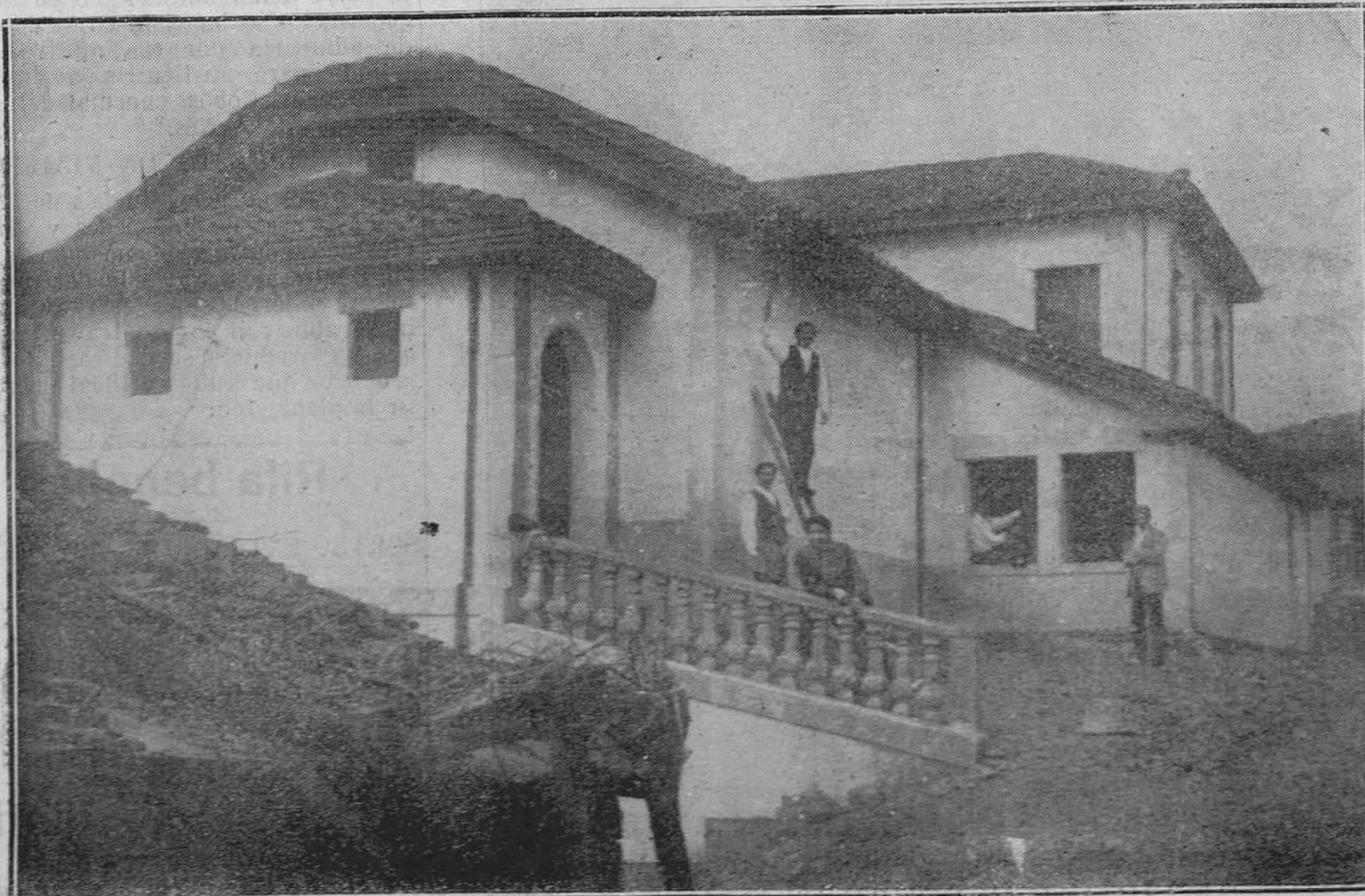
TURON.—Escuela próxima a inaugurarse, construída a expensas de la Sociedad 'Hulleras del Turón', en el Valle Alto de Urbés.
