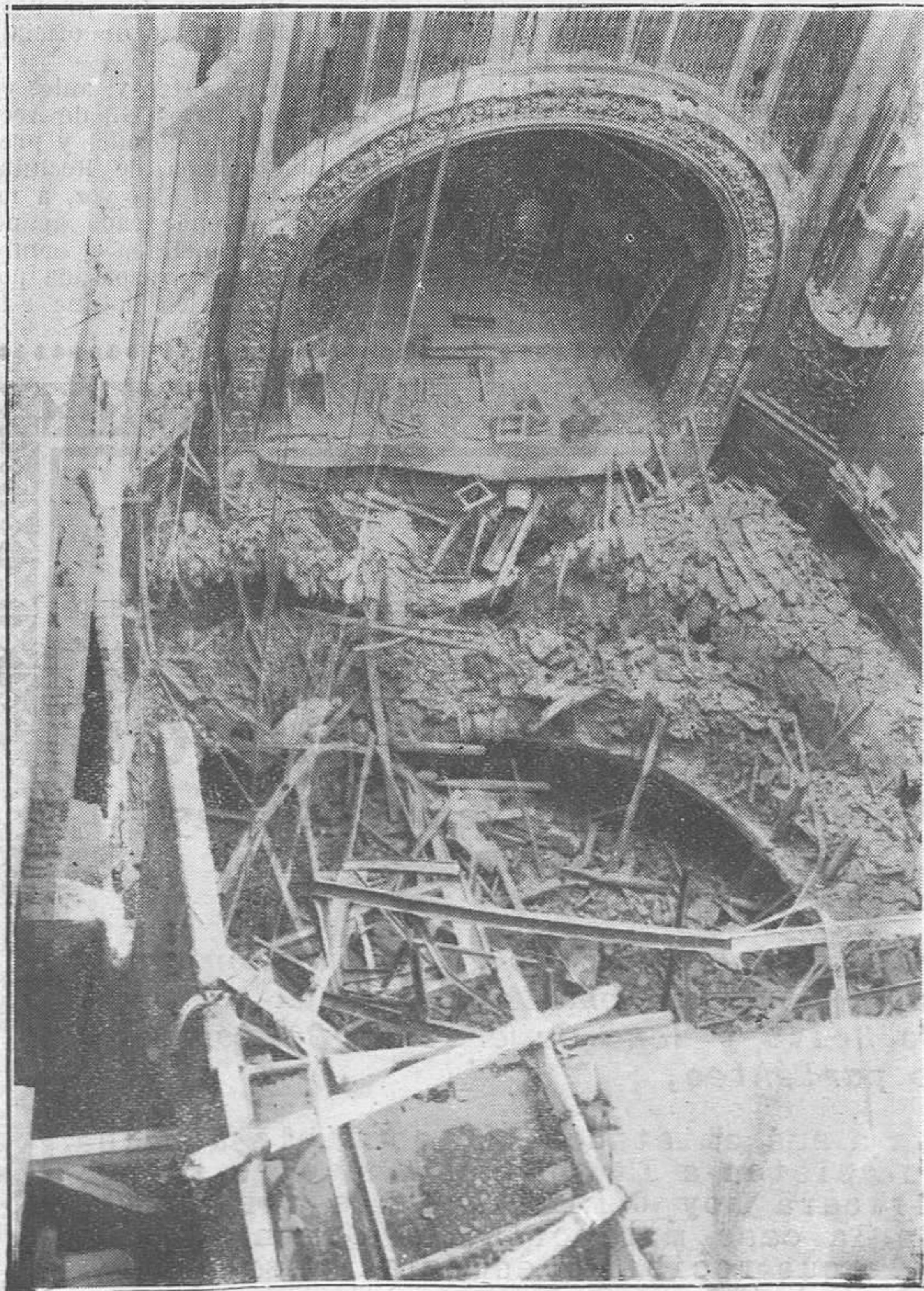
MADRID.—Un aspecto del hundimiento ocurrido esta mañana en un nuevo cine de la Gran-Vía, cuya inauguración debía verificarse dentro de poco tiempo. (Foto Vidan)
