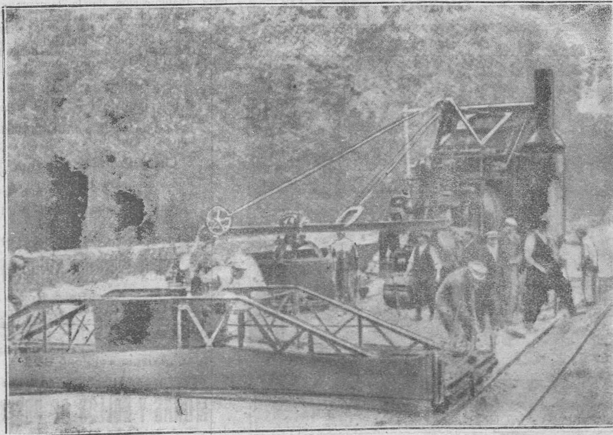
CONSTRUCCION DE UNA CARRETERA FRANCESA CON HORMIGON.—Cómo se efectuarán mecánicamente las primeras operaciones.
