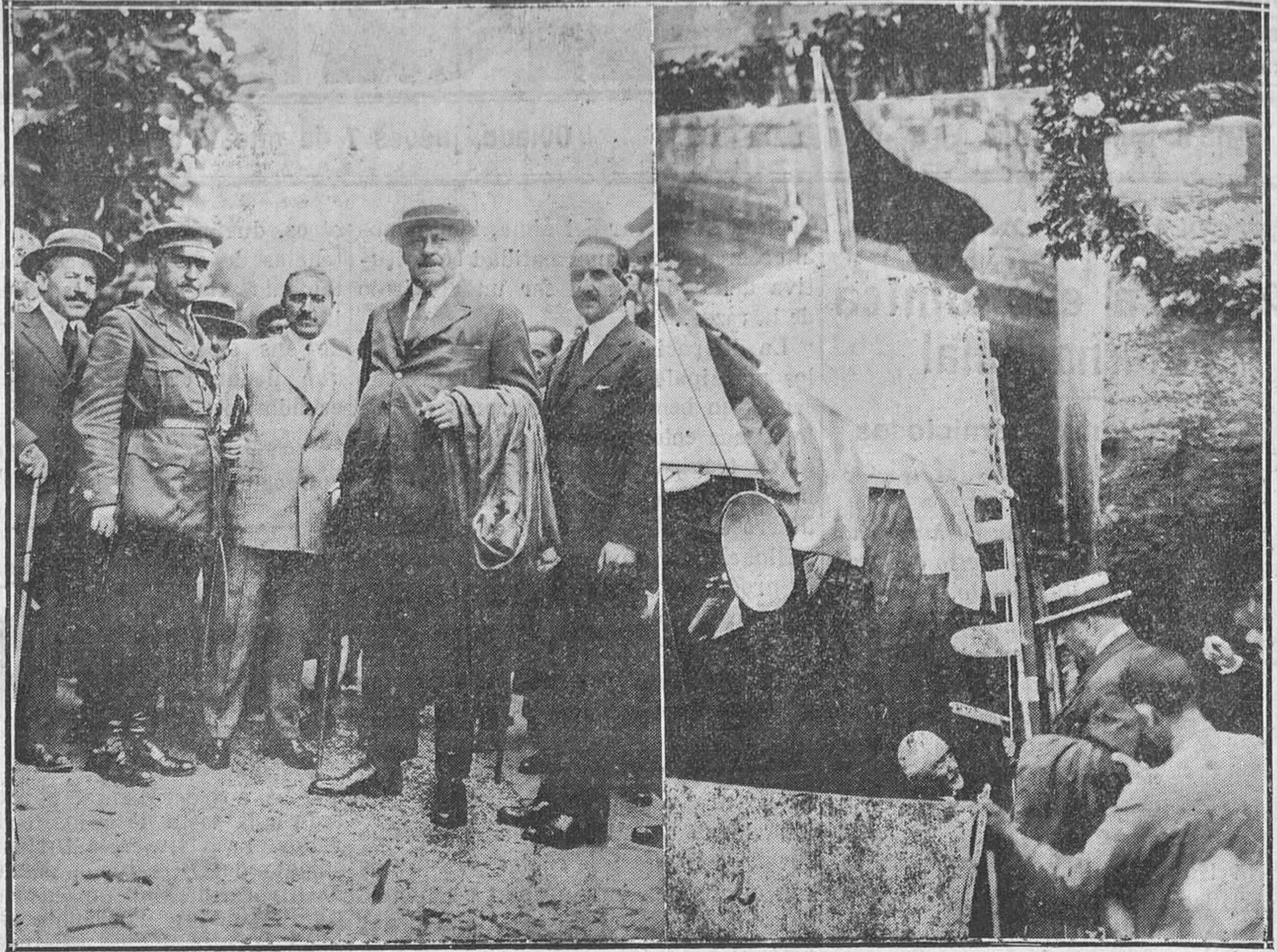
1, El marqués de Estella en la estación de San Esteban de Pravia.—2, El general Primo de Rivera en el momento de embarcar en la gasolinera para visitar las obras del Puerto. (Fotos Buelta)
