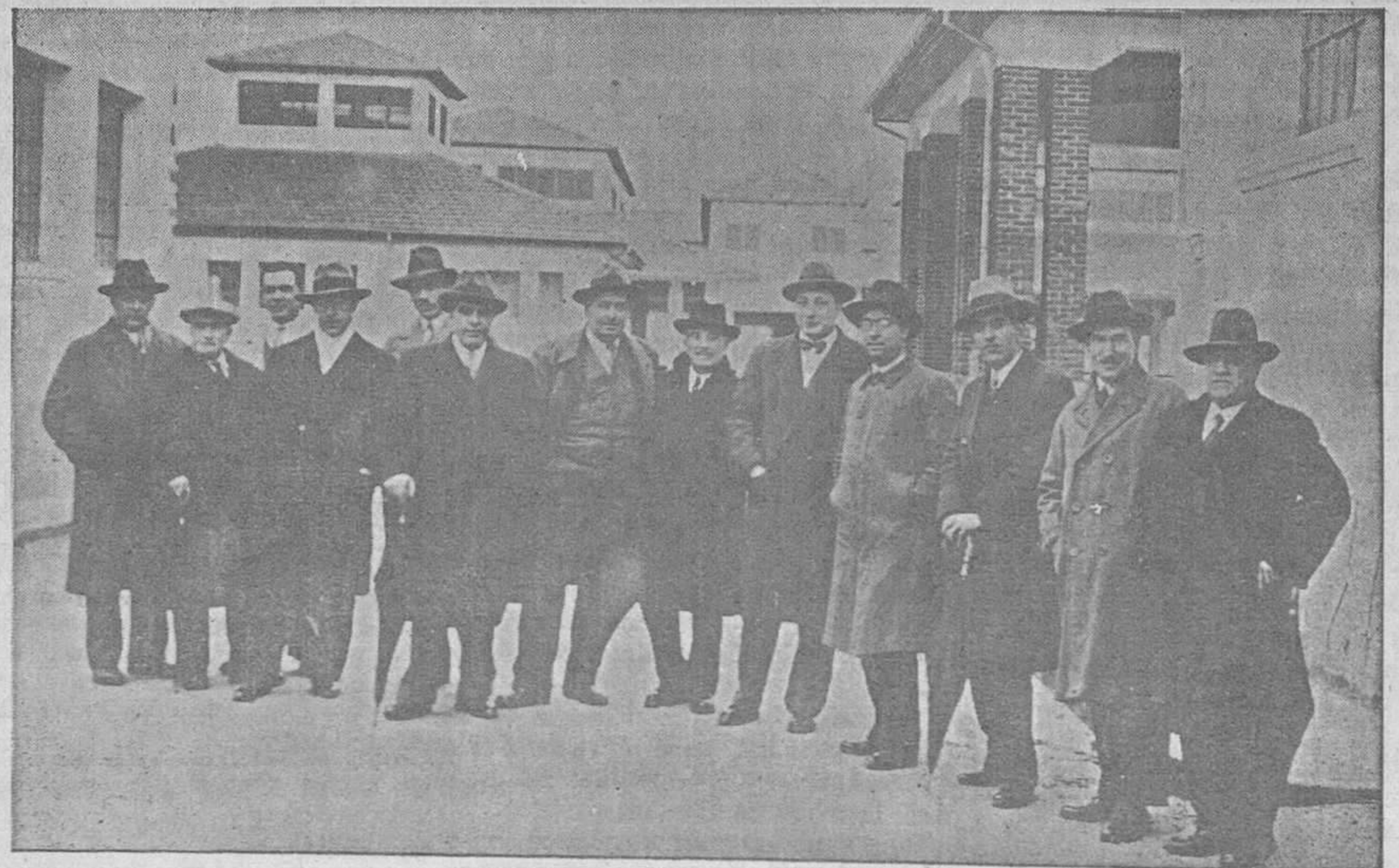
EN EL NUEVO MATADERO DE OVIEDO.—Los concejales que forman la Comisión especial con los técnicos del Municipio, después de haber presenciado las pruebas que con satisfactorio resultado se hicieron ayer de los elementos mecánicos del nuevo gran edificio del concejo y que son preliminares obligados para la entrega oficial y definitiva
