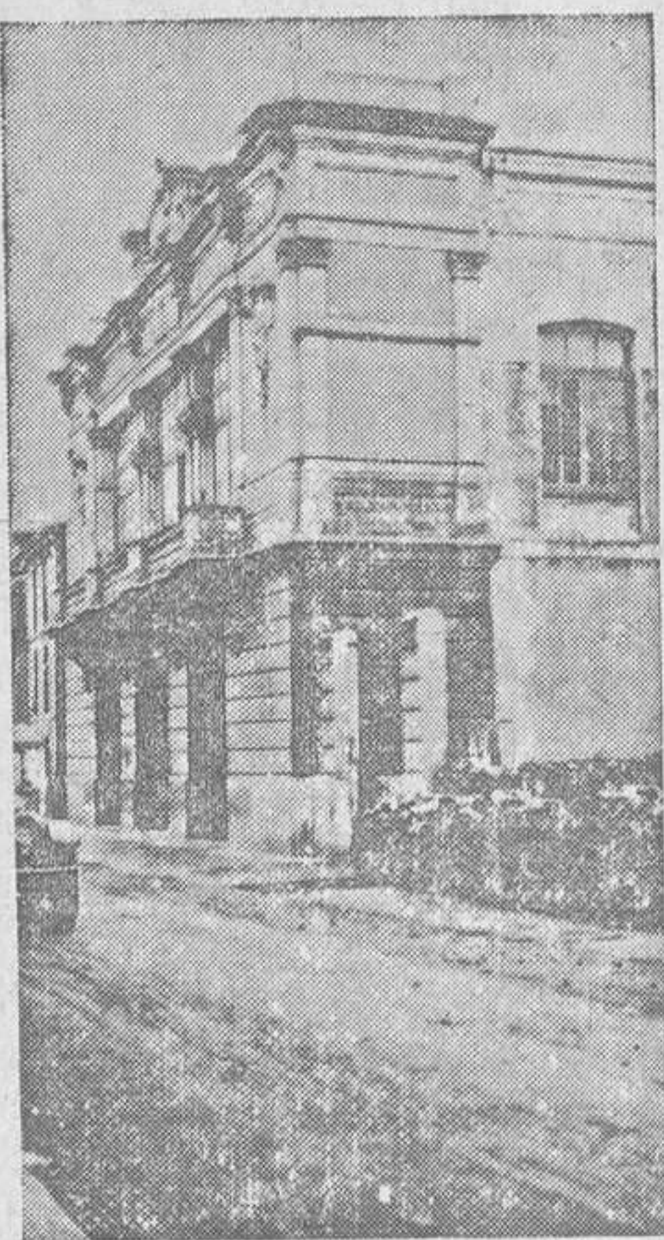
CASA CENTRAL DEL SINDICATO AGRICOLA DE PILOÑA
