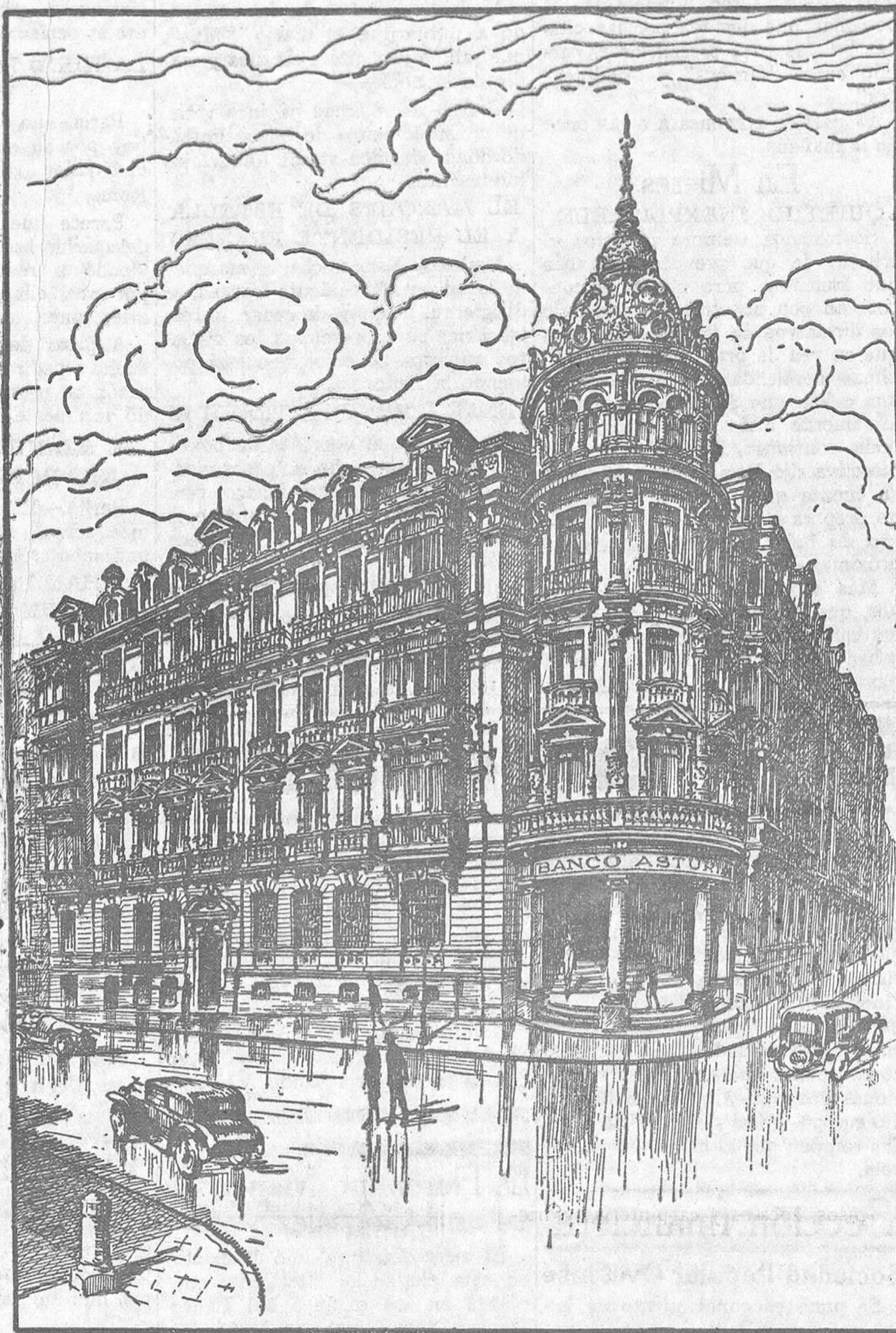
VISTA DE CONJUNTO DEL MAGNIFICO EDIFICIO, PROPIEDAD DEL BANCO ASTURIANO, QUE MIDE CIENTO METROS LINEALES DE FACHADA
