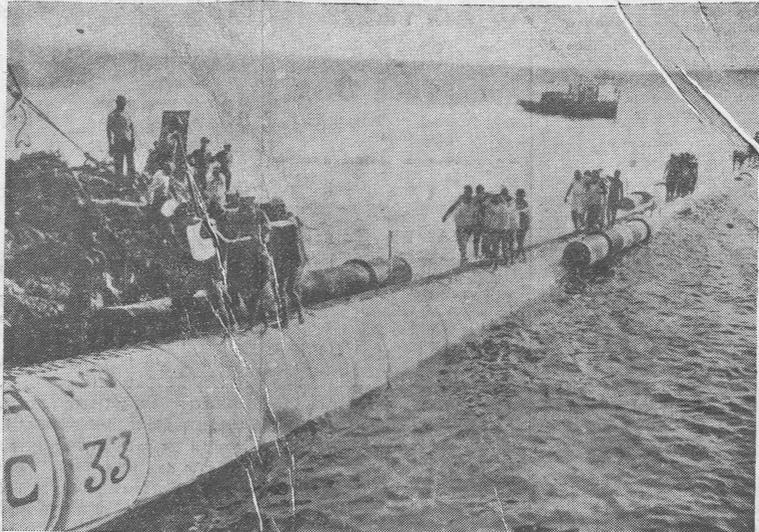
Matanzas (Cuba).—Instalación del tubo metálico ideado y construido por el profesor Georges Claude, mediante el cual el inventor pretende producir fluido eléctrico barato, aprovechando las diferencias térmicas de Imar
