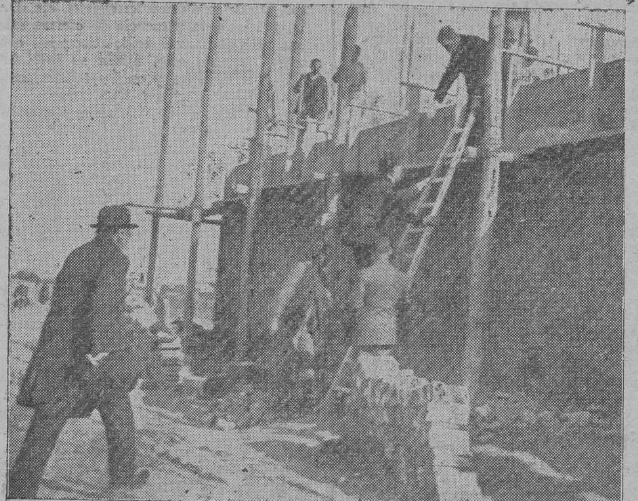
Don Alfonso subiendo al andamio para examinar las obras
