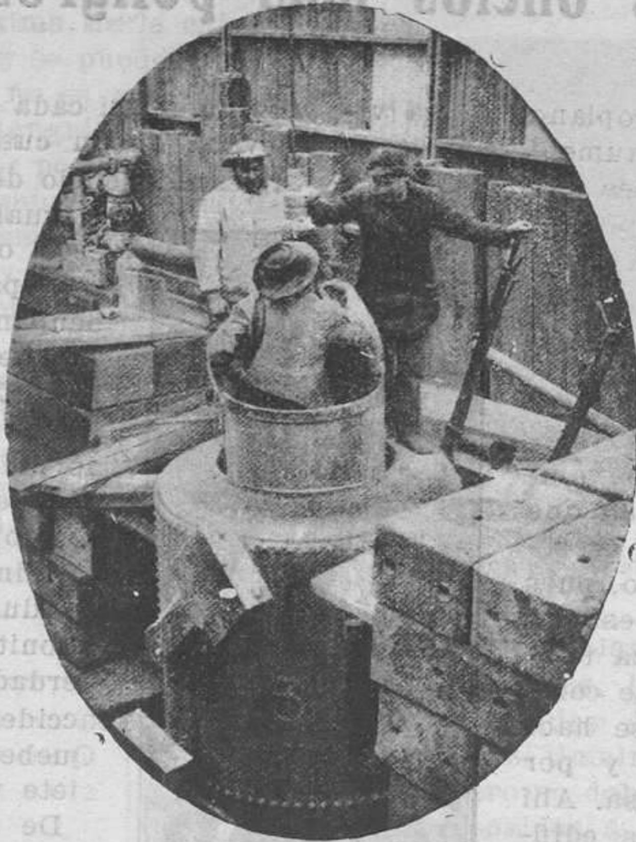
Bajando á un túnel en construcción para un ferrocarril subterráneo.
