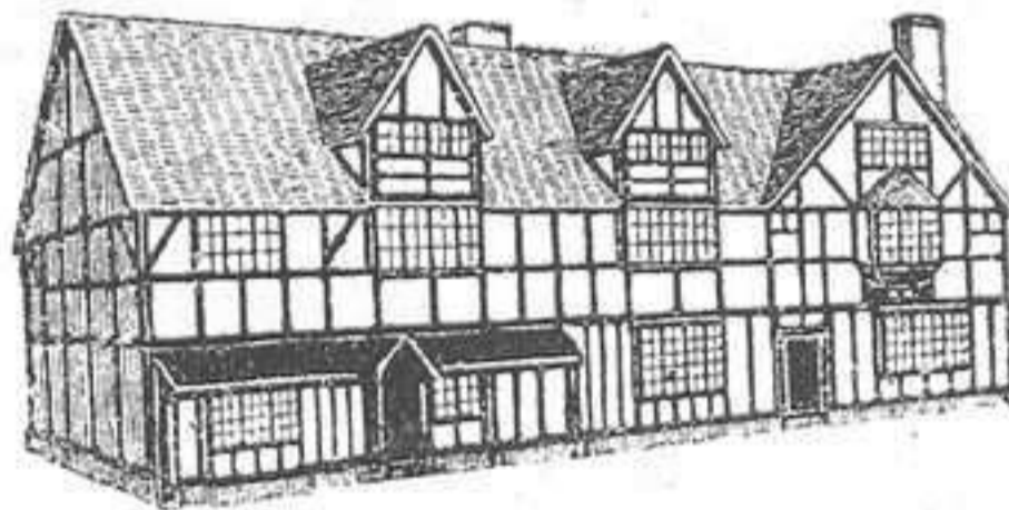
2. LA CASA ACABADA
