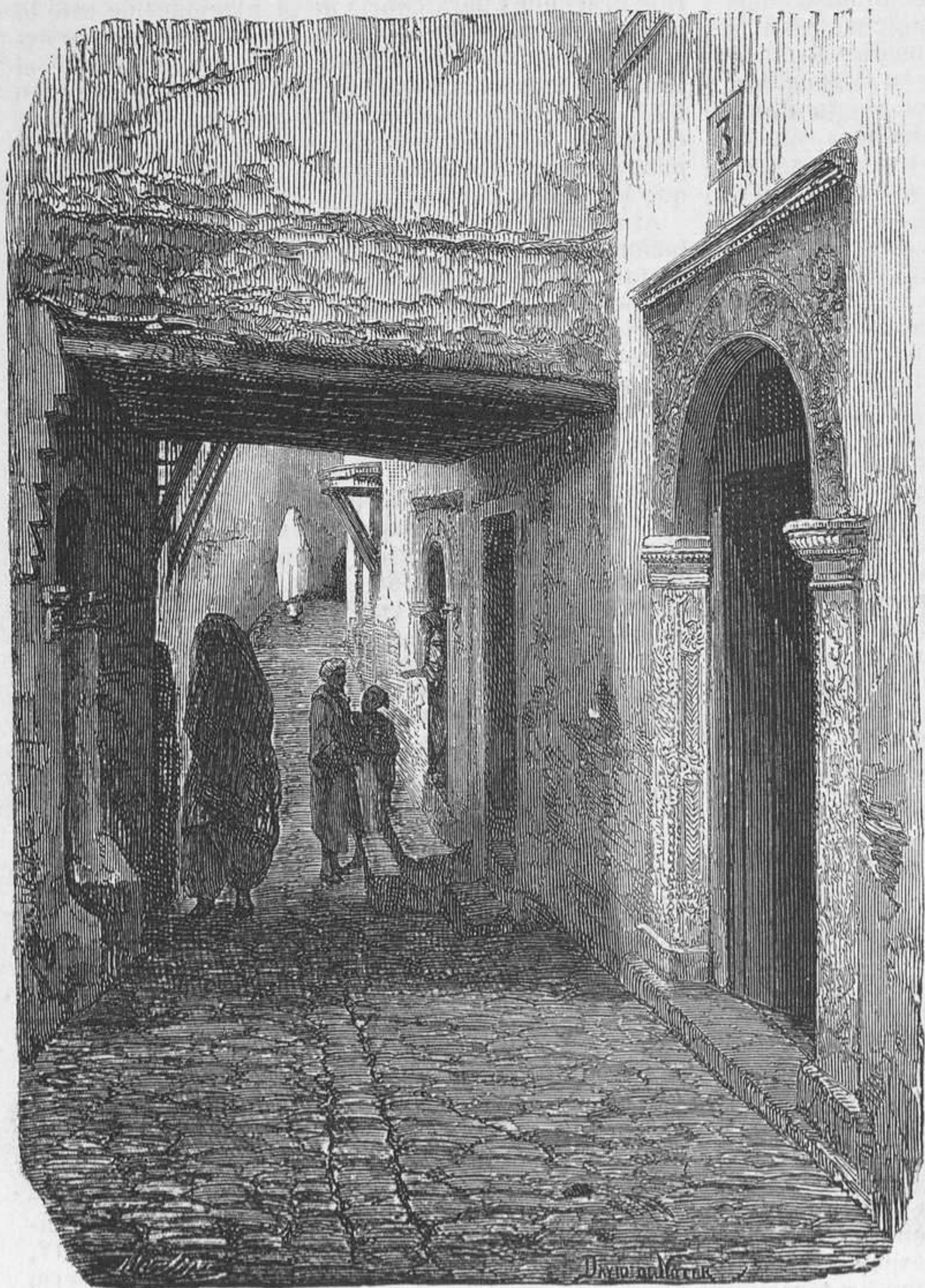
Entrada de una casa morisca.
