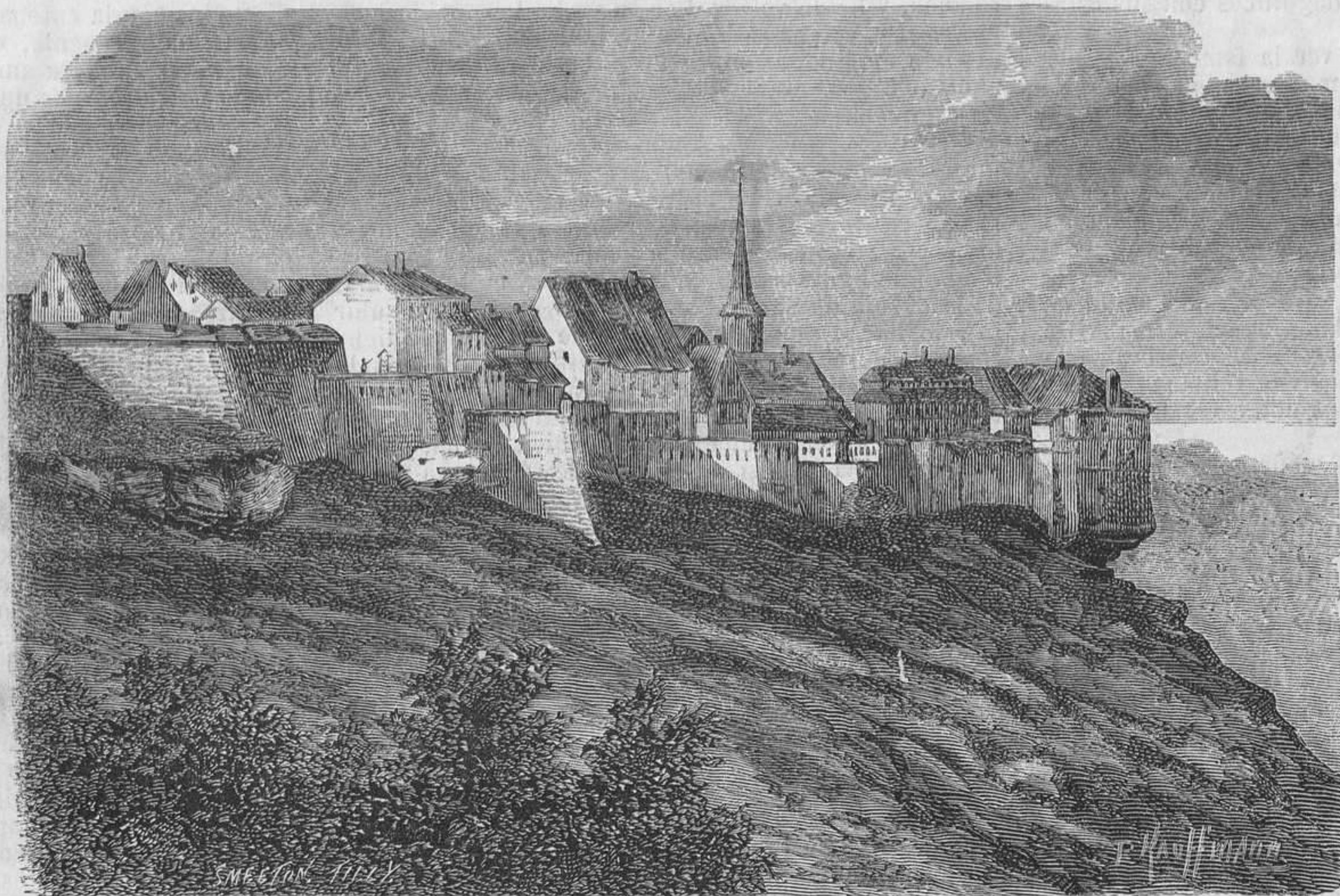
Fortaleza de la Petite-Pierre (Bajo Rhin), demolida por los prusianos.
