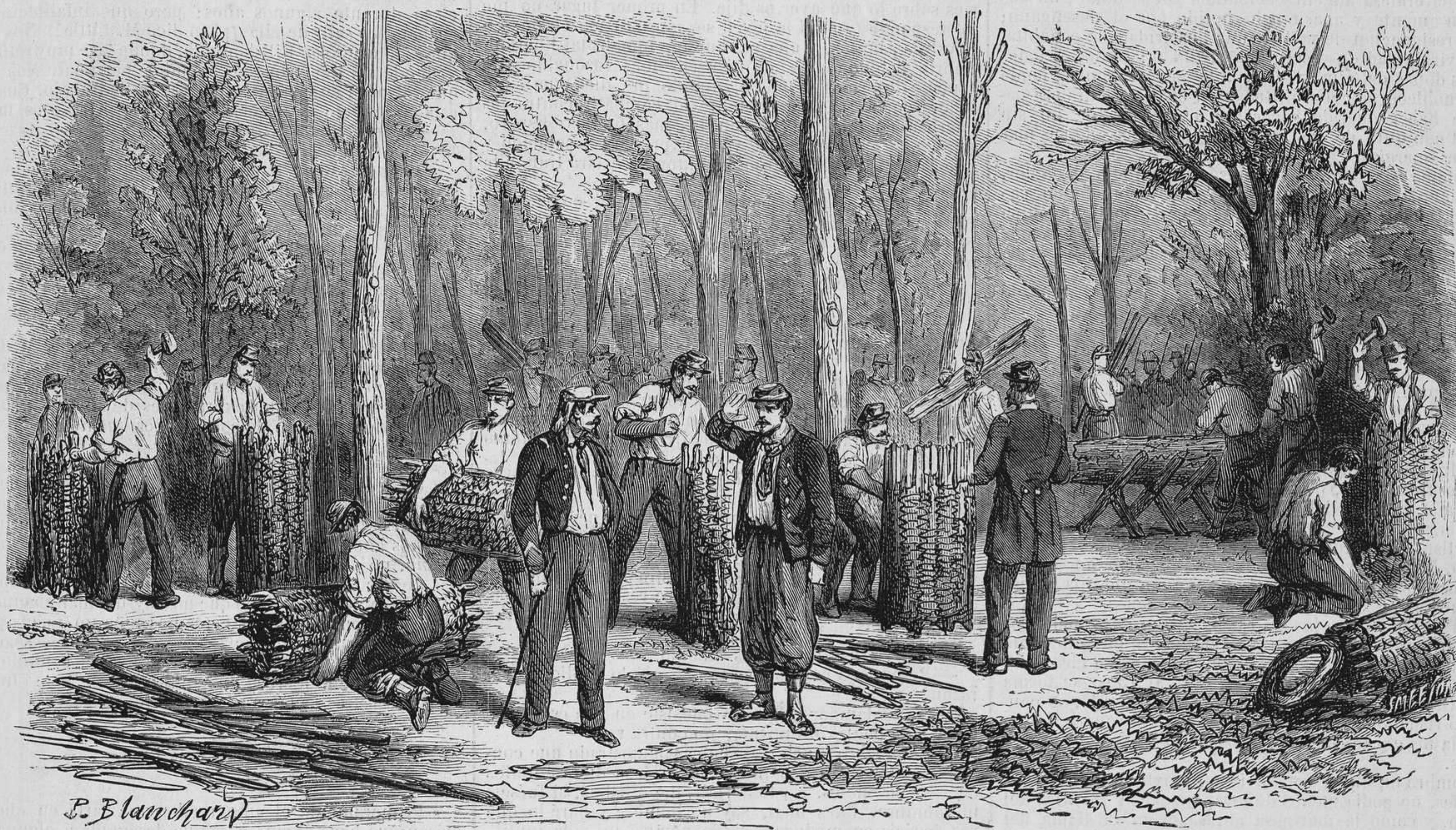
La fabricacion de gabiones.
