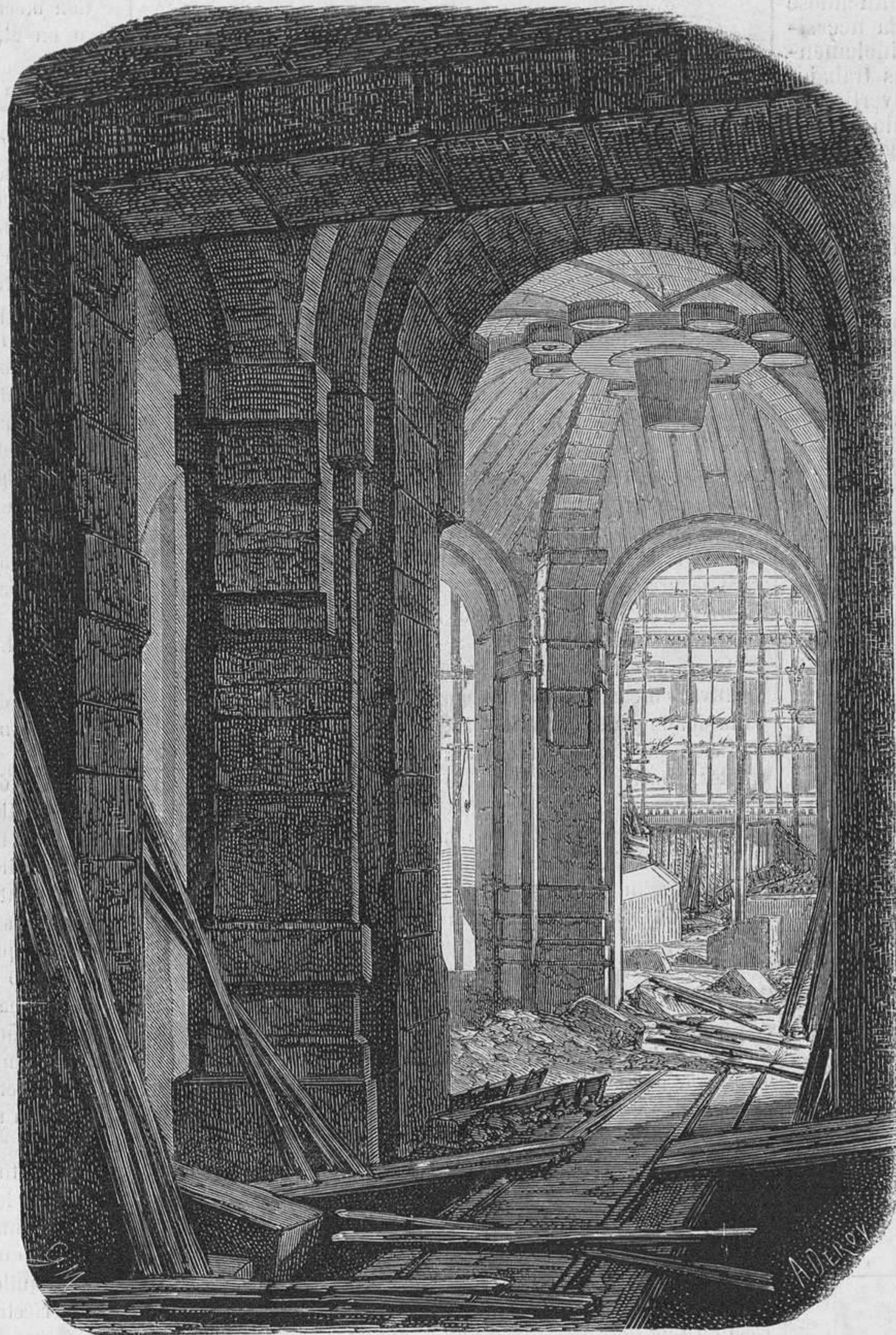
LAS OBRAS DEL NUEVO TEATRO DE LA ÓPERA : Vestíbulo á cubierto para los coches
