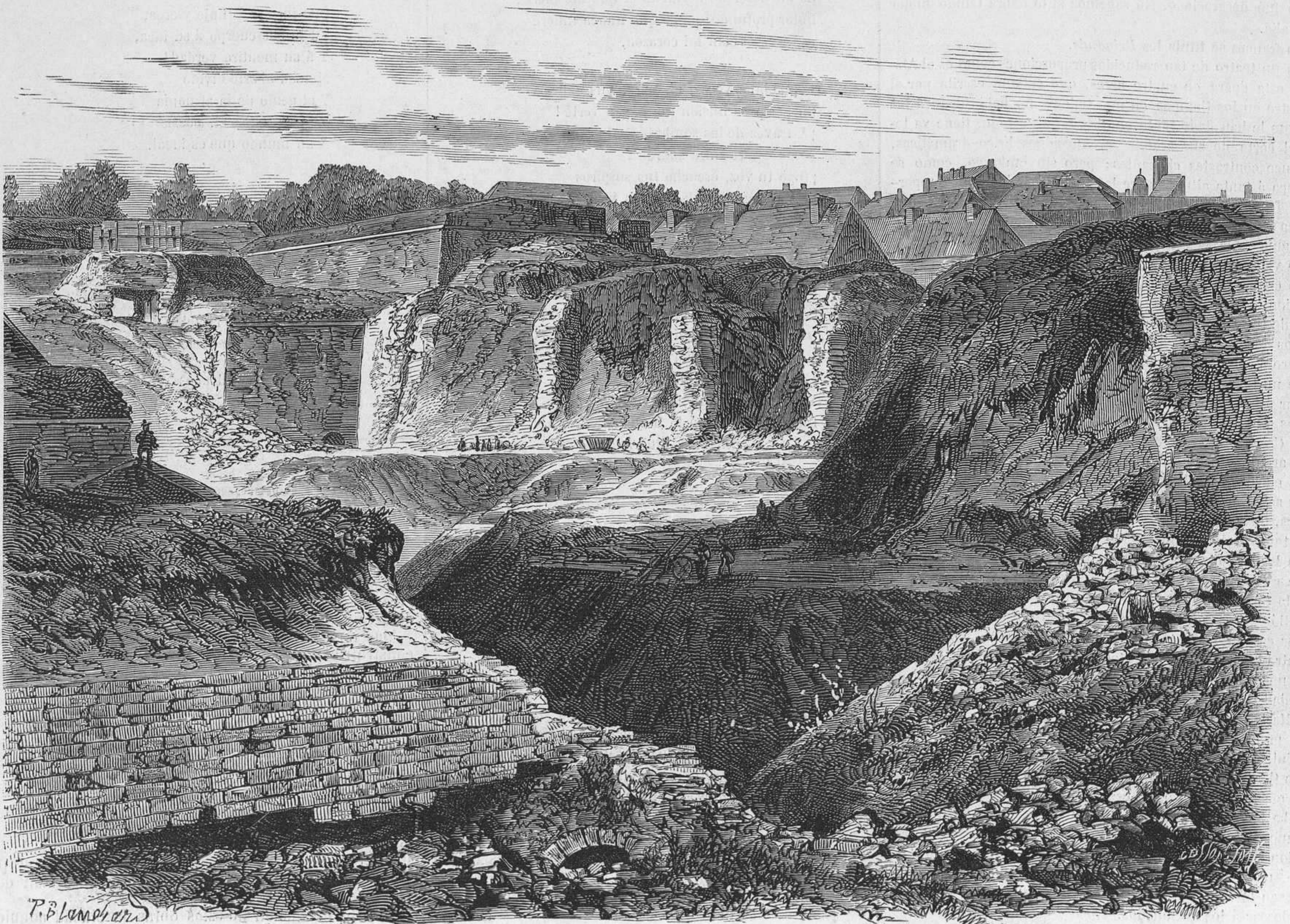
DEMOLICIONES DE LUXEMBURGO. — Nivelacion del primer recinto.
