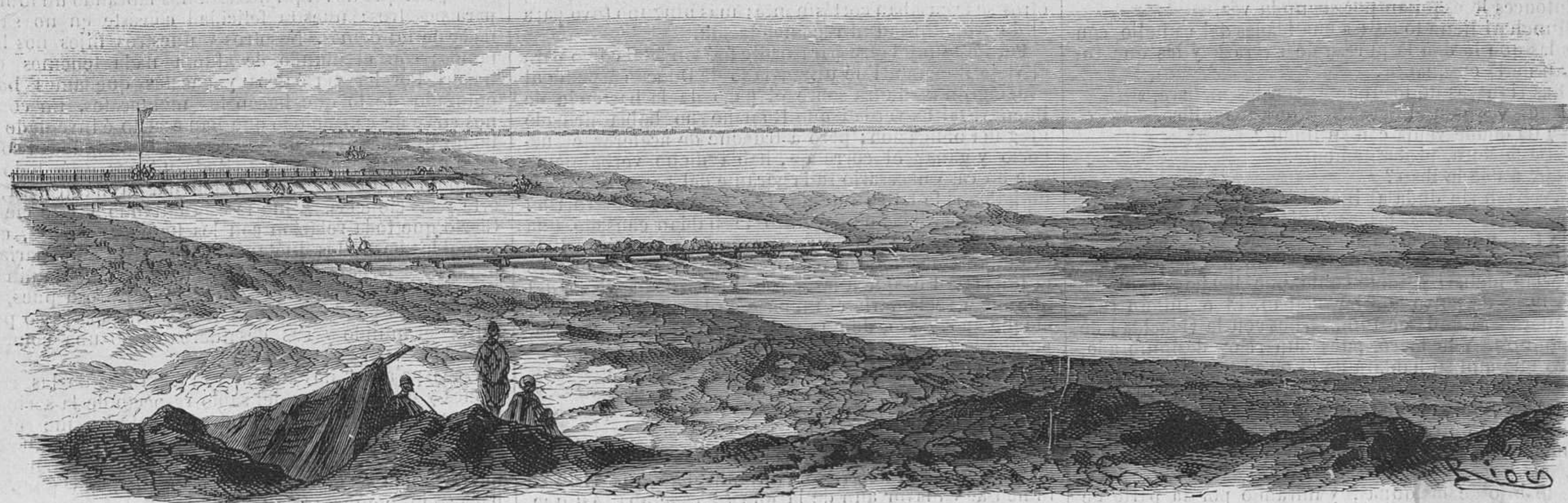
Istmo de Suez. — Aspecto de los lagos Amargos: el Desagüe.
