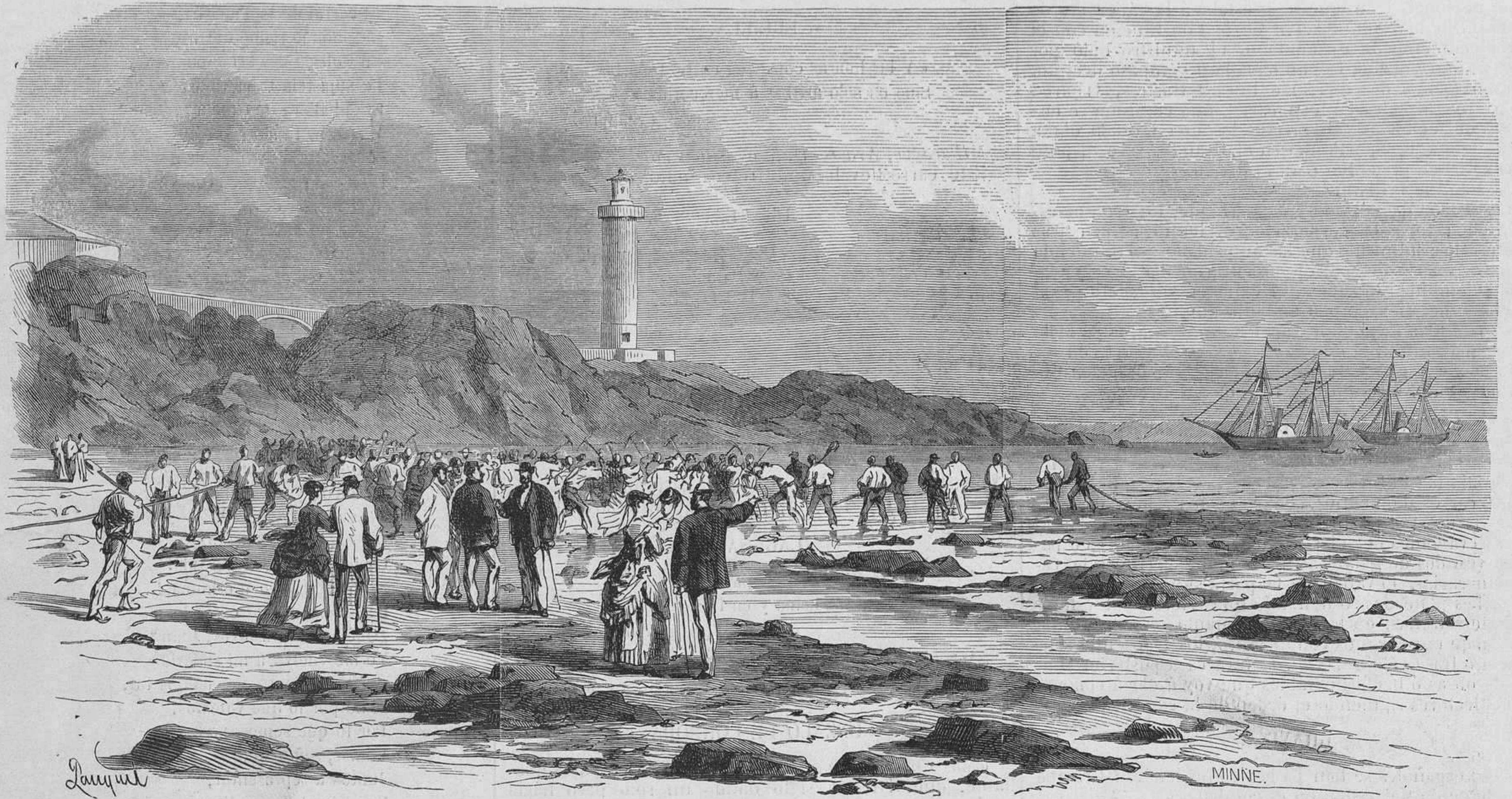
Cable trasatlántico francés. — Colocacion del grueso cable costero á la entrada de la ensenada de Minou, cerca de Brest.
