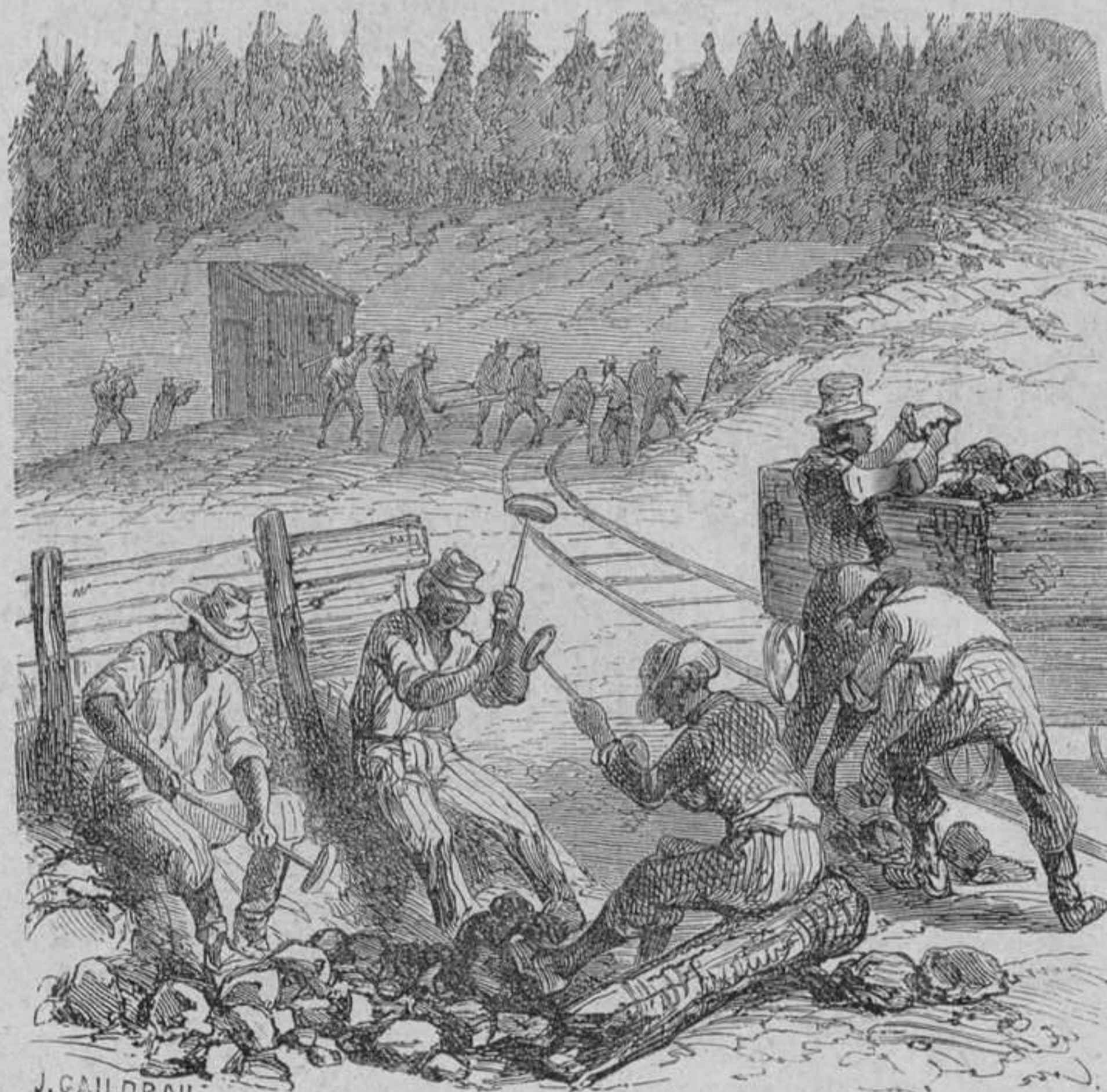
Negros construyendo un camino.
