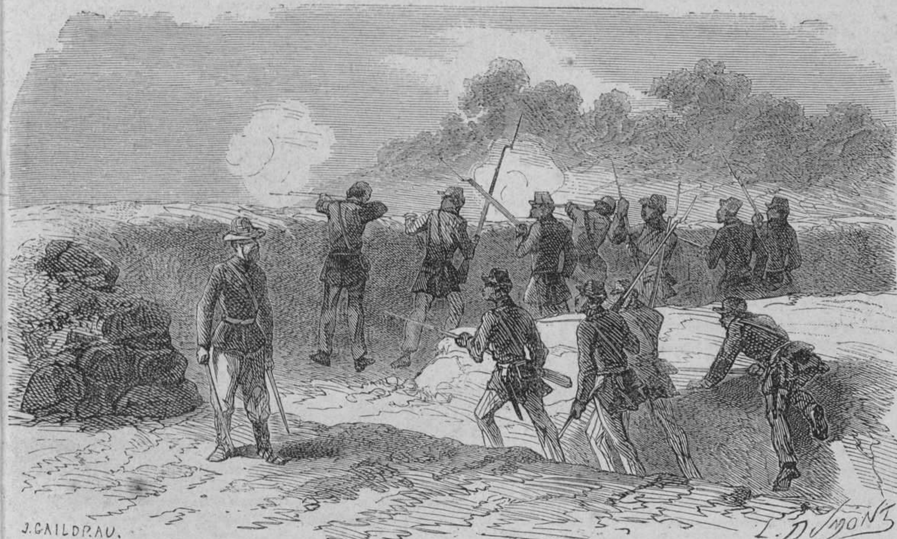
Los negros en la trinchera.
