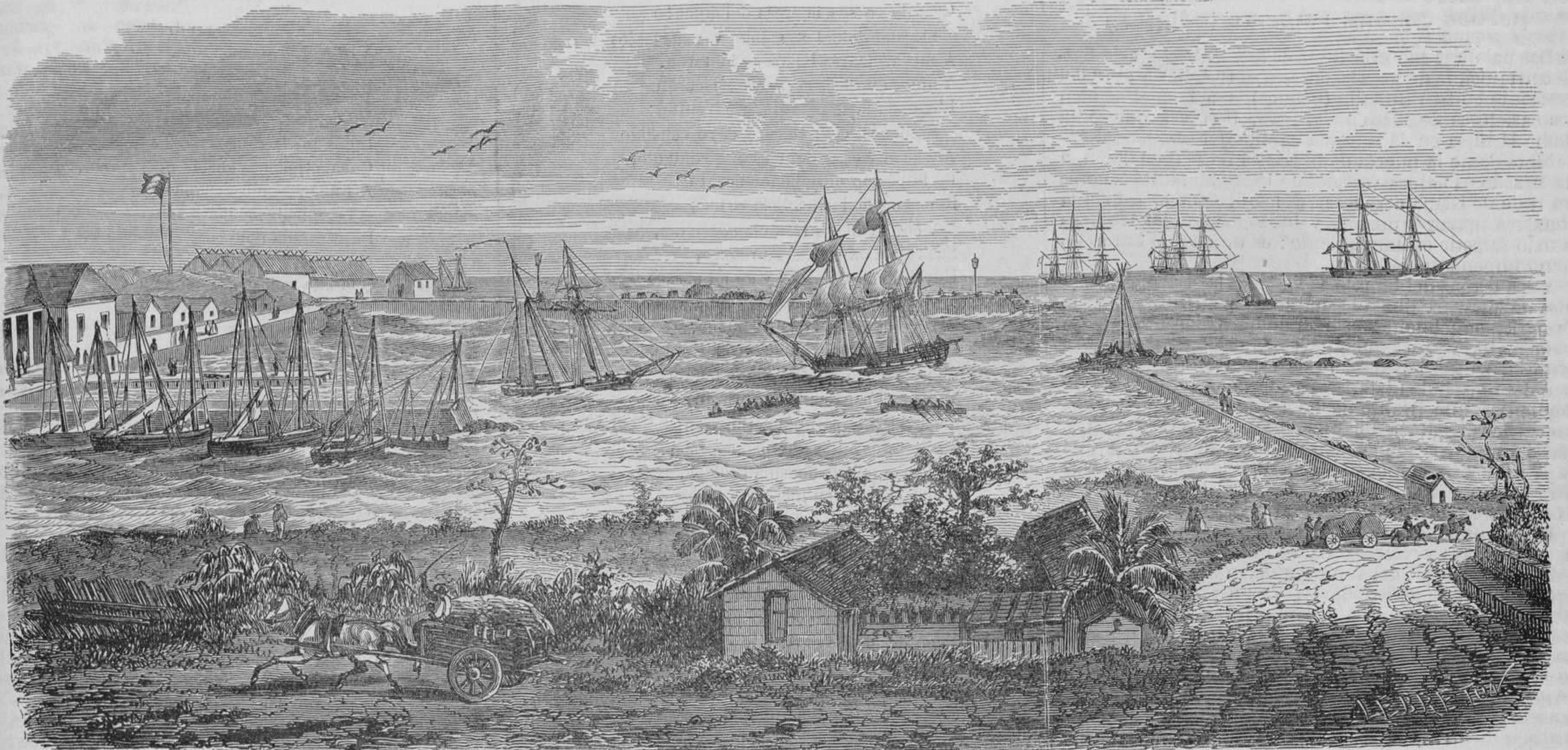
OBRAS DEL PUERTO DE SAN PEDRO (ISLA DE LA REUNION), VISTA TOMADA DEL MASTIL DE SEÑALES.
