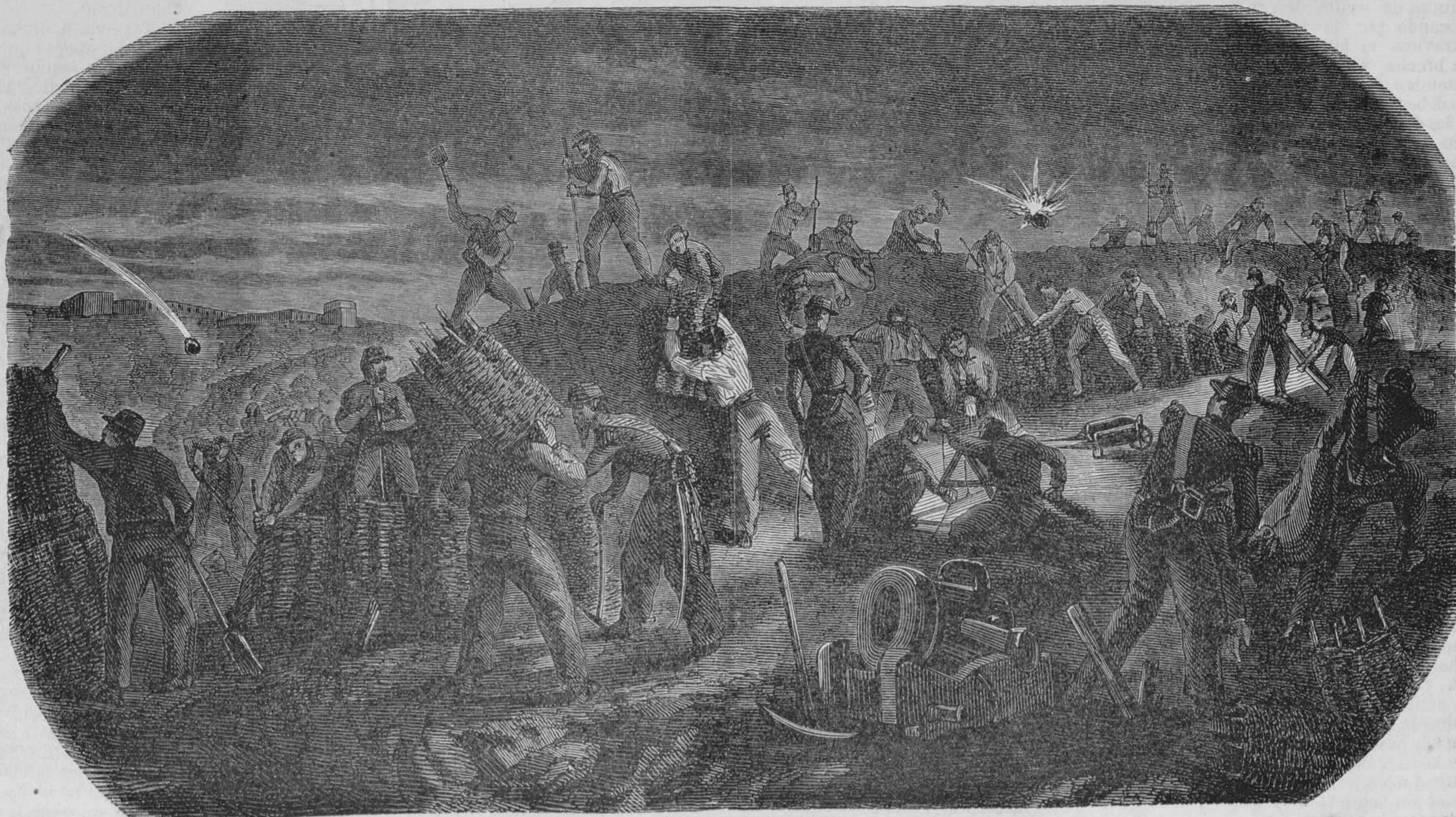
CONSTRUCCION DE UNA BATERIA DE SITIO.
