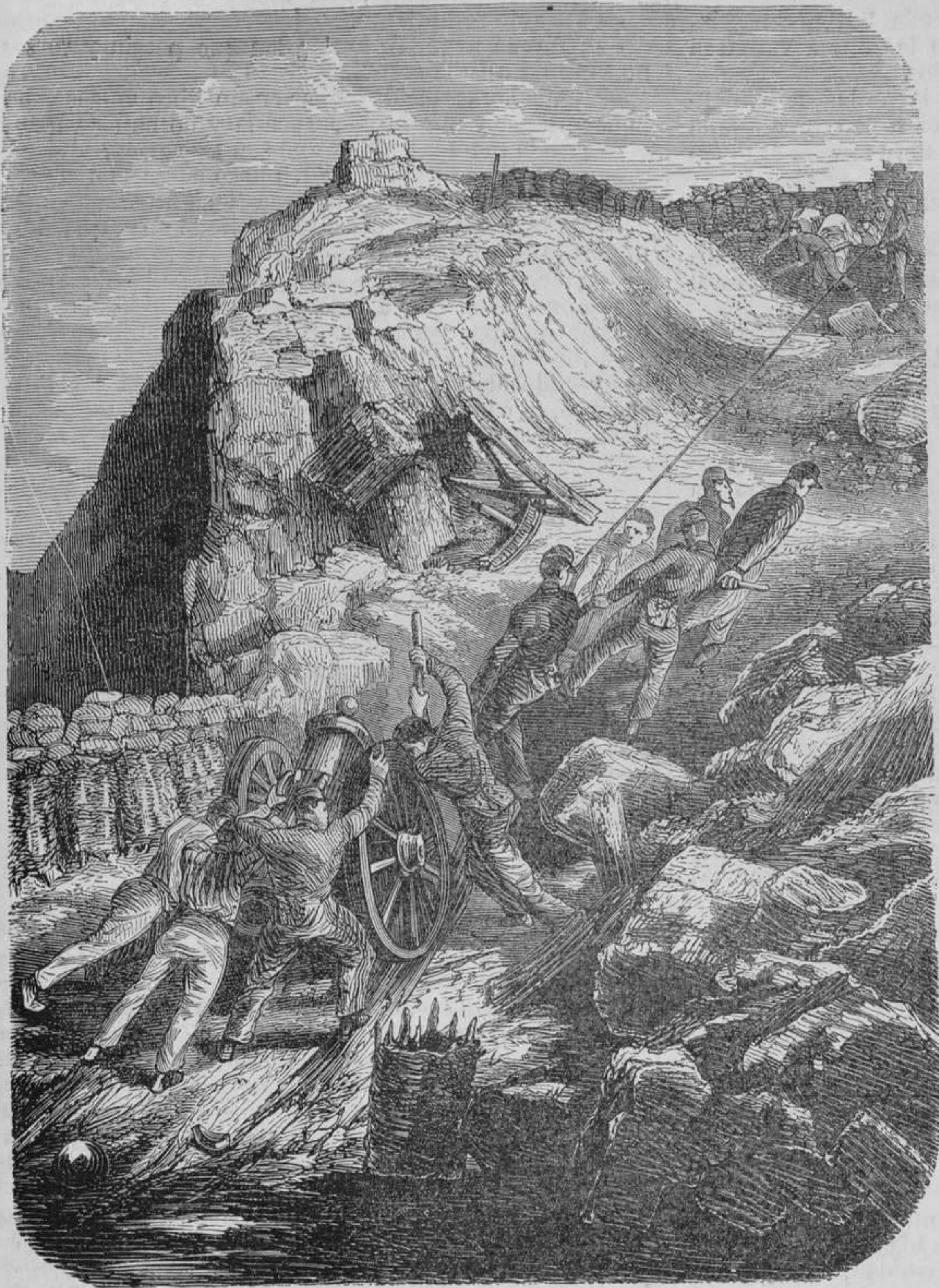
CORONAMIENTO DE UNA BRECHA.
