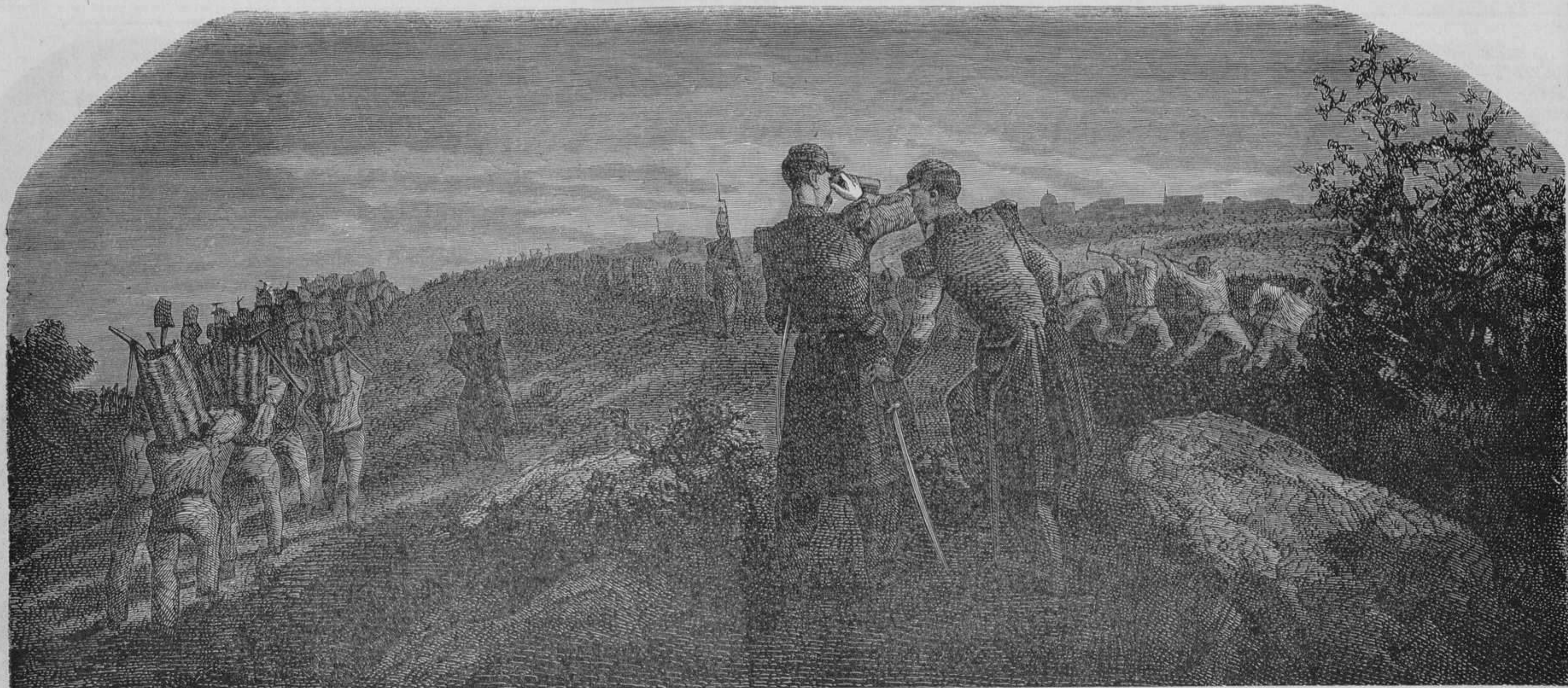
ARTE MILITAR. — ABERTURA DE UNA TRINCHERA.
