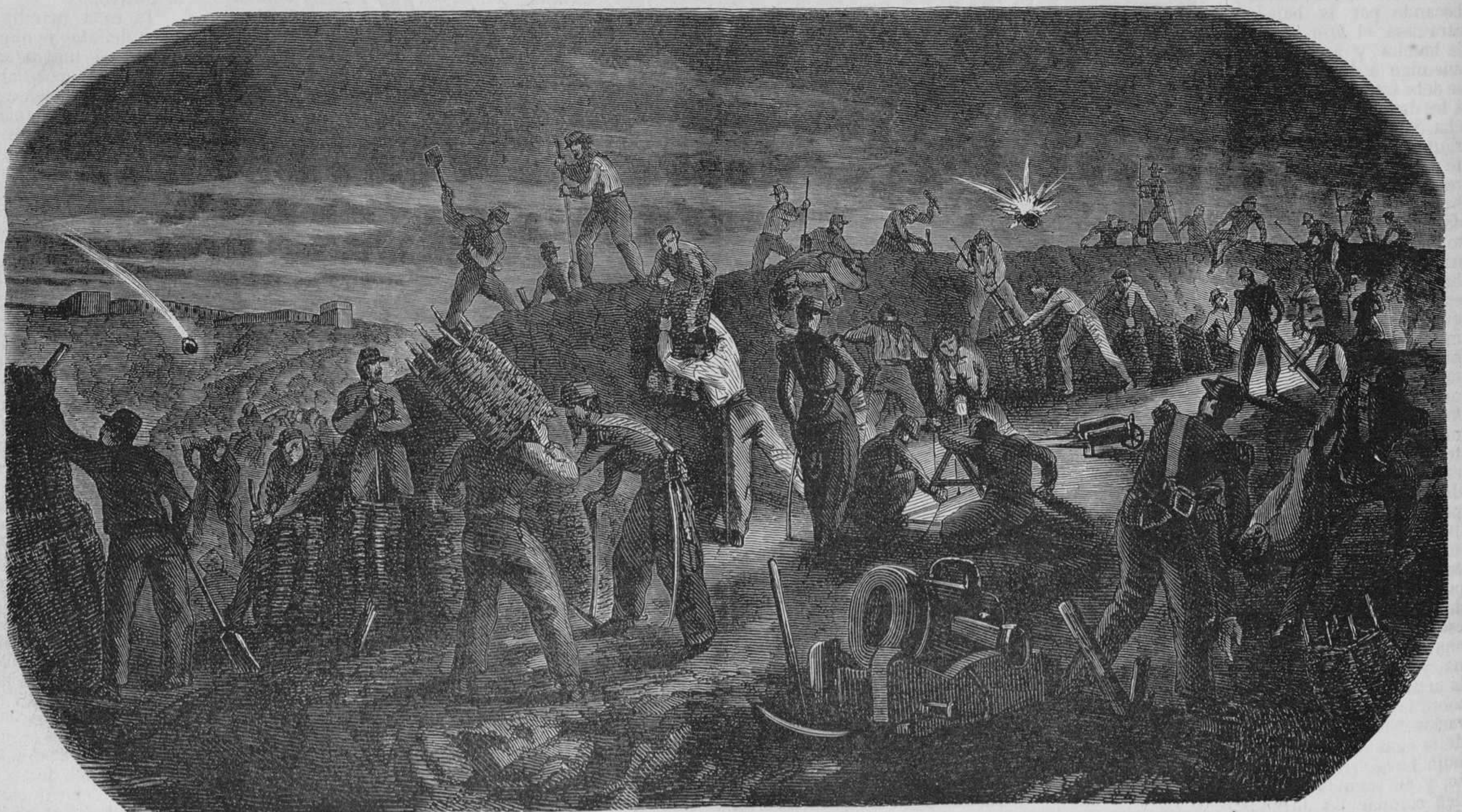
CONSTRUCCION DE UNA BATERIA DE SITIO.
