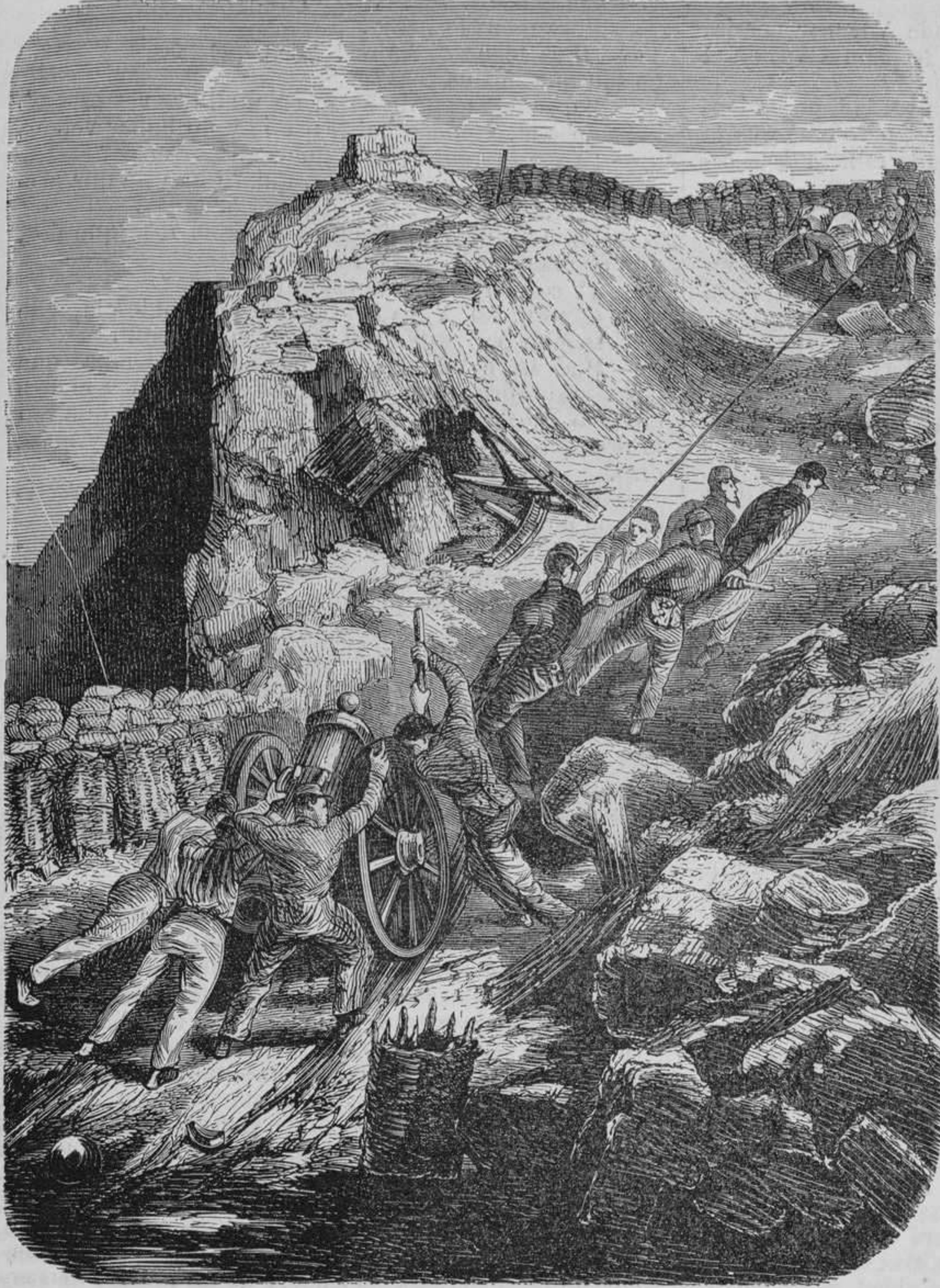
CORONAMIENTO DE UNA BRECHA.
