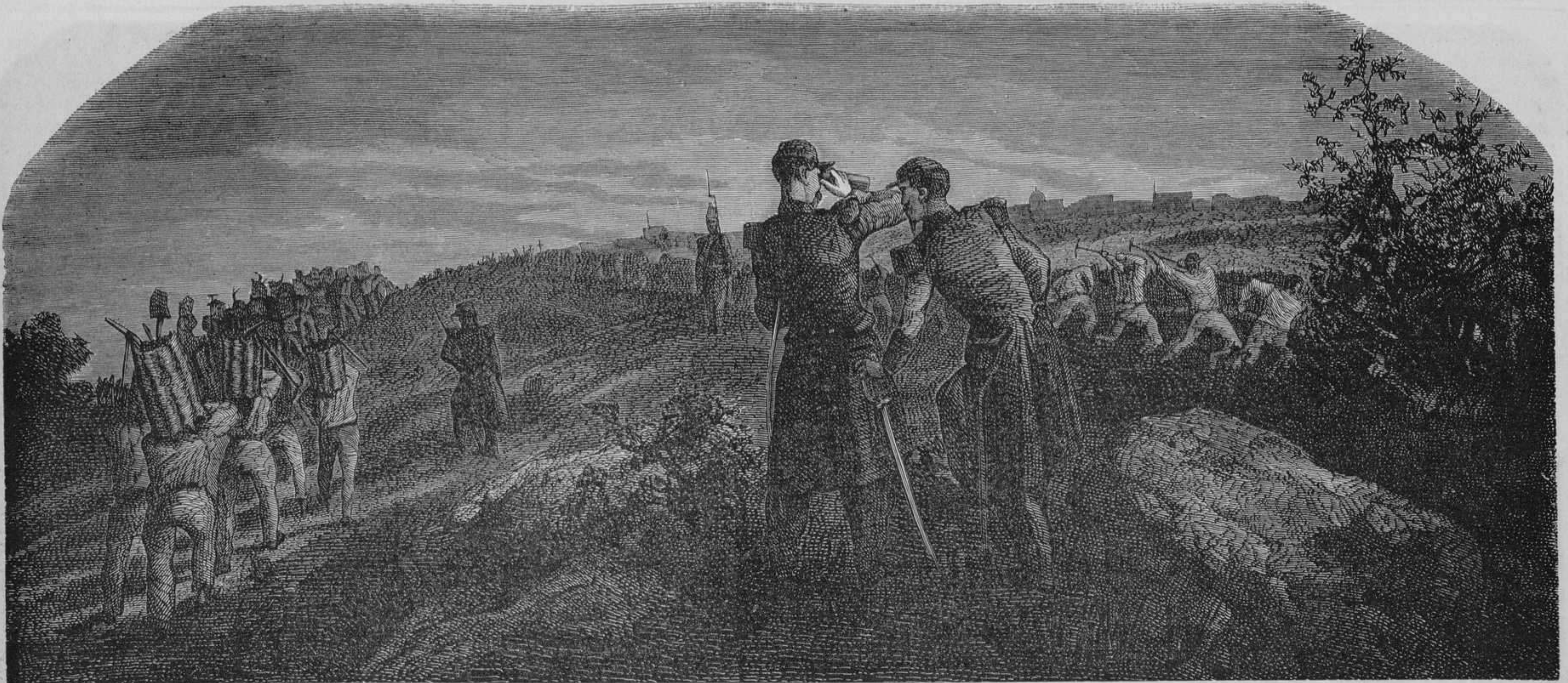
ARTE MILITAR. — ABERTURA DE UNA TRINCHERA.
