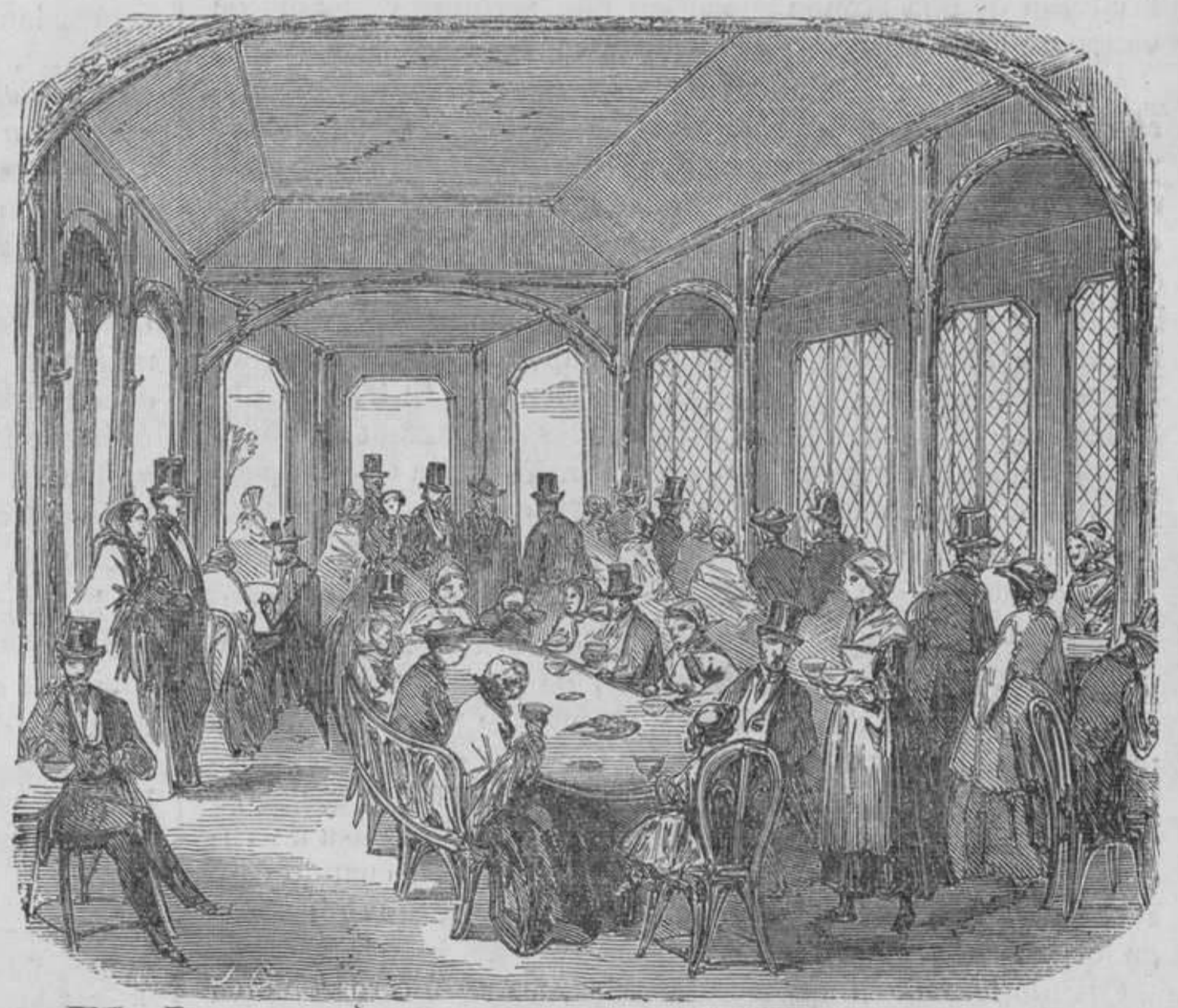
LA LECHERIA, VISTA INTERIOR.
