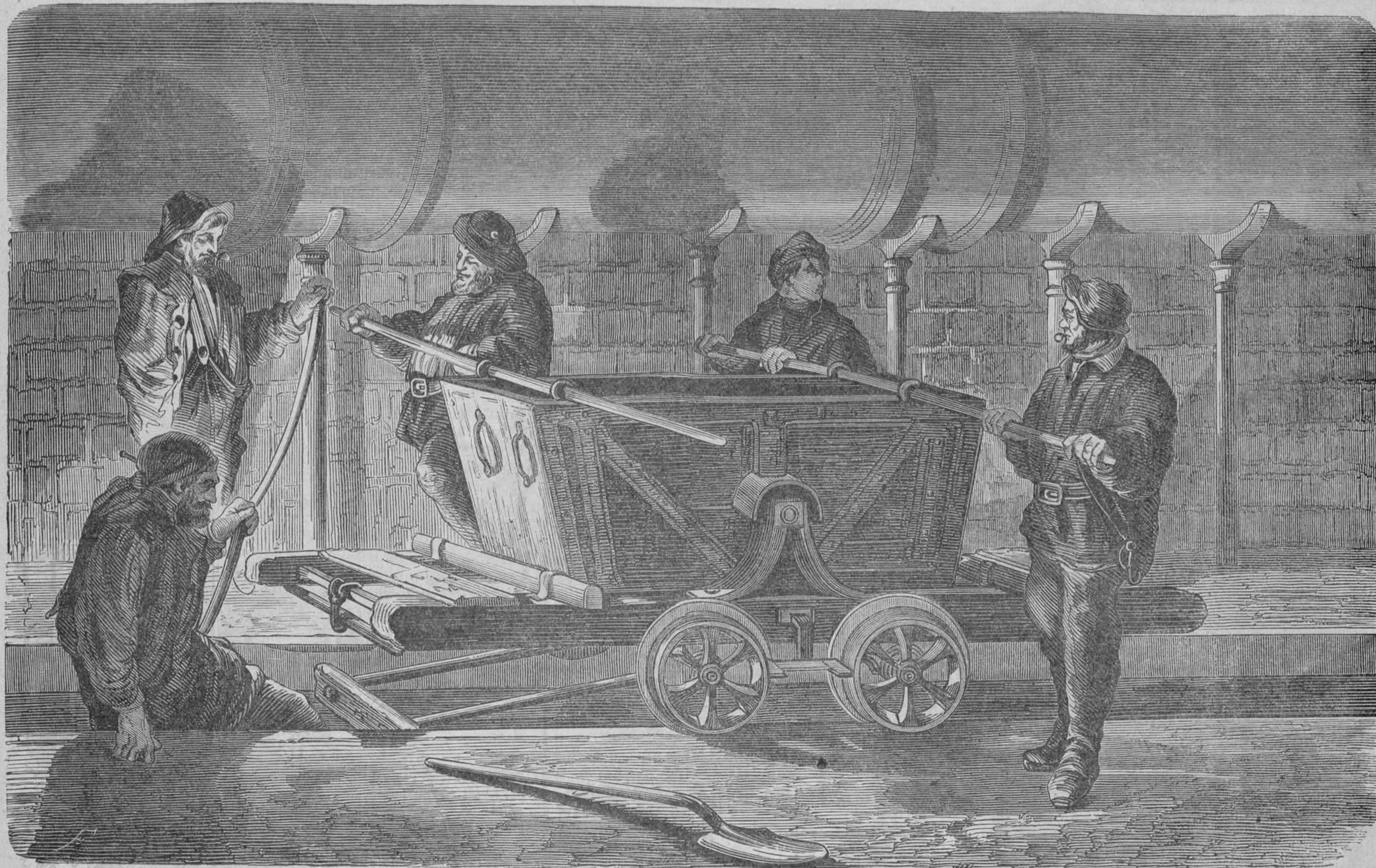
Obras subterráneas del boulevard de Sebastopol. Wagon para la limpieza de la alcantarilla y para el transporte de las inmundicias.
