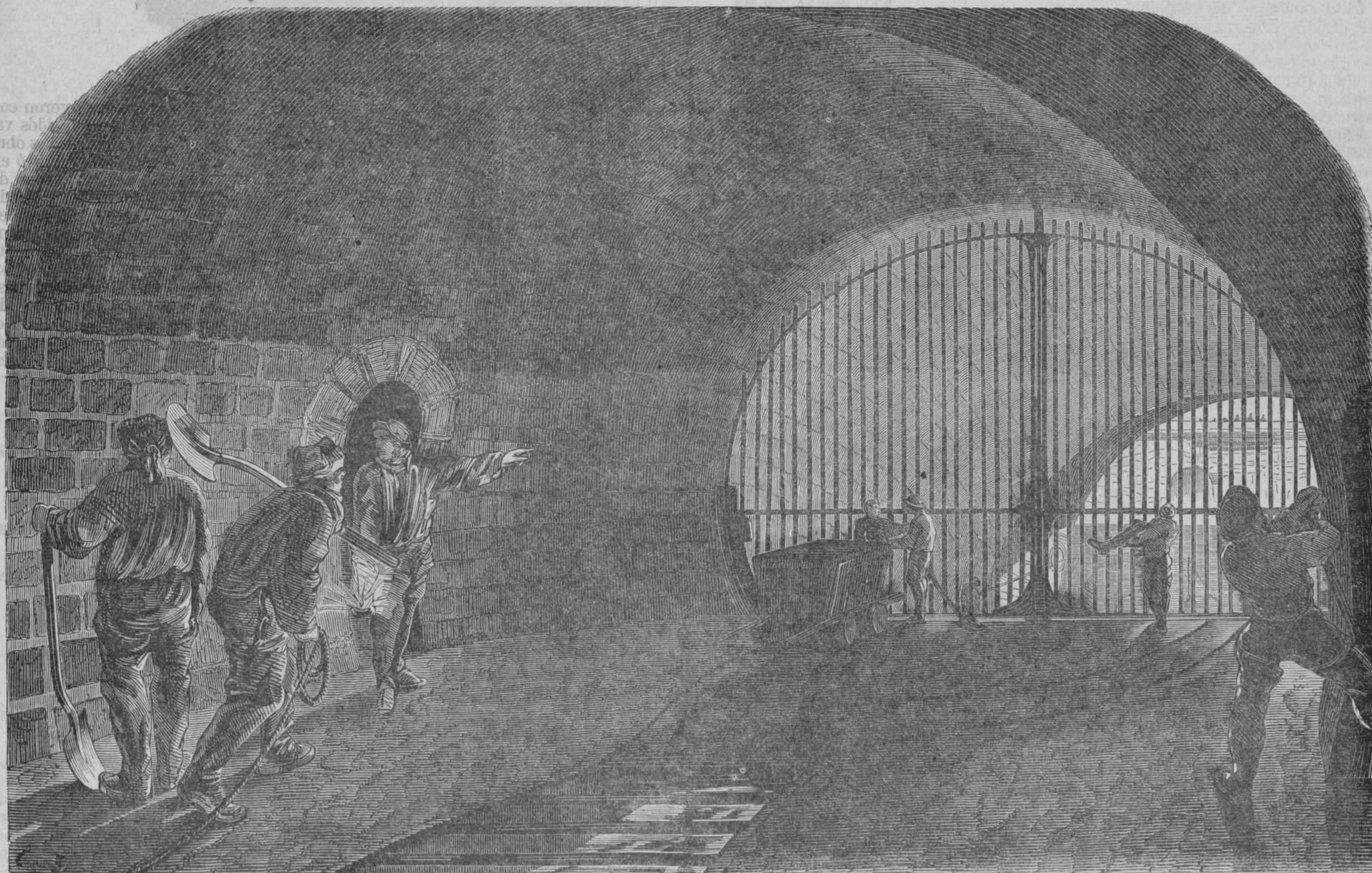
Punto en que la alcantarilla sale al Sena.
