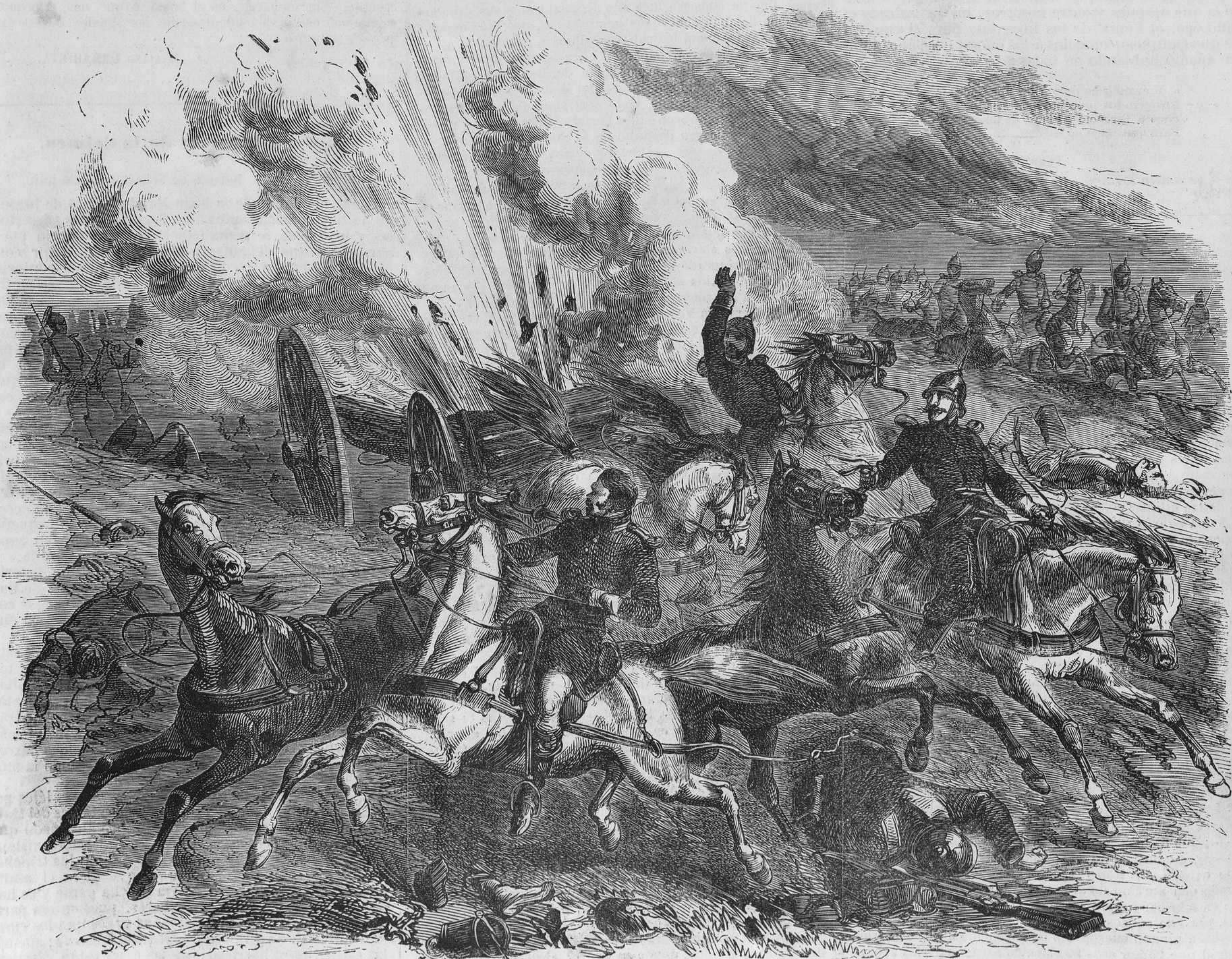
Explosion de un arcon de la artillería rusa.
