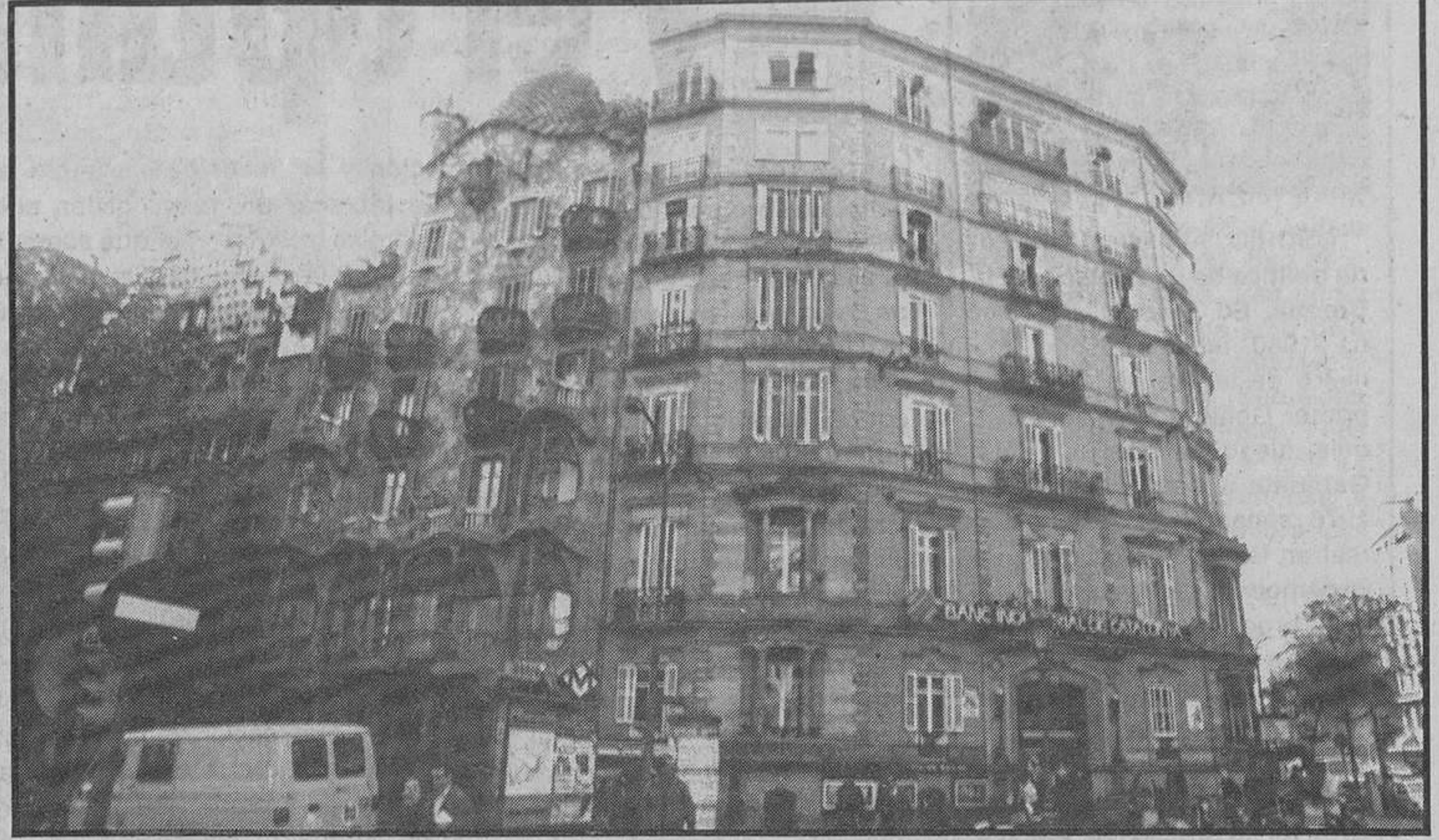
Obsérvese cómo queda eclipsada la Casa Batlló por los pisos añadidos a una finca del Paseo de Gracia, esquina Aragón. (Foto: Soteras)
