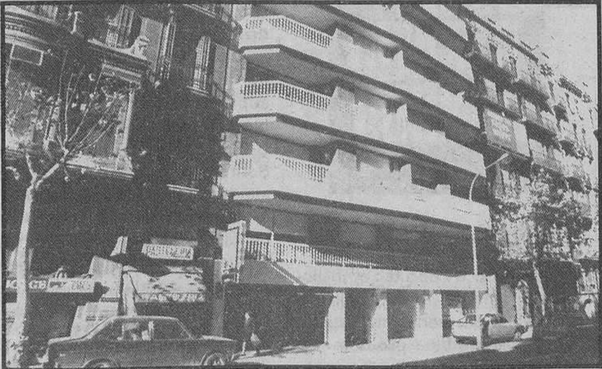
Las balconadas horizontales rompen la estética del Eixample. En la foto, uno de los edificios que se construyen «en serie» por todo el ensanche. (Foto: Soteras)
