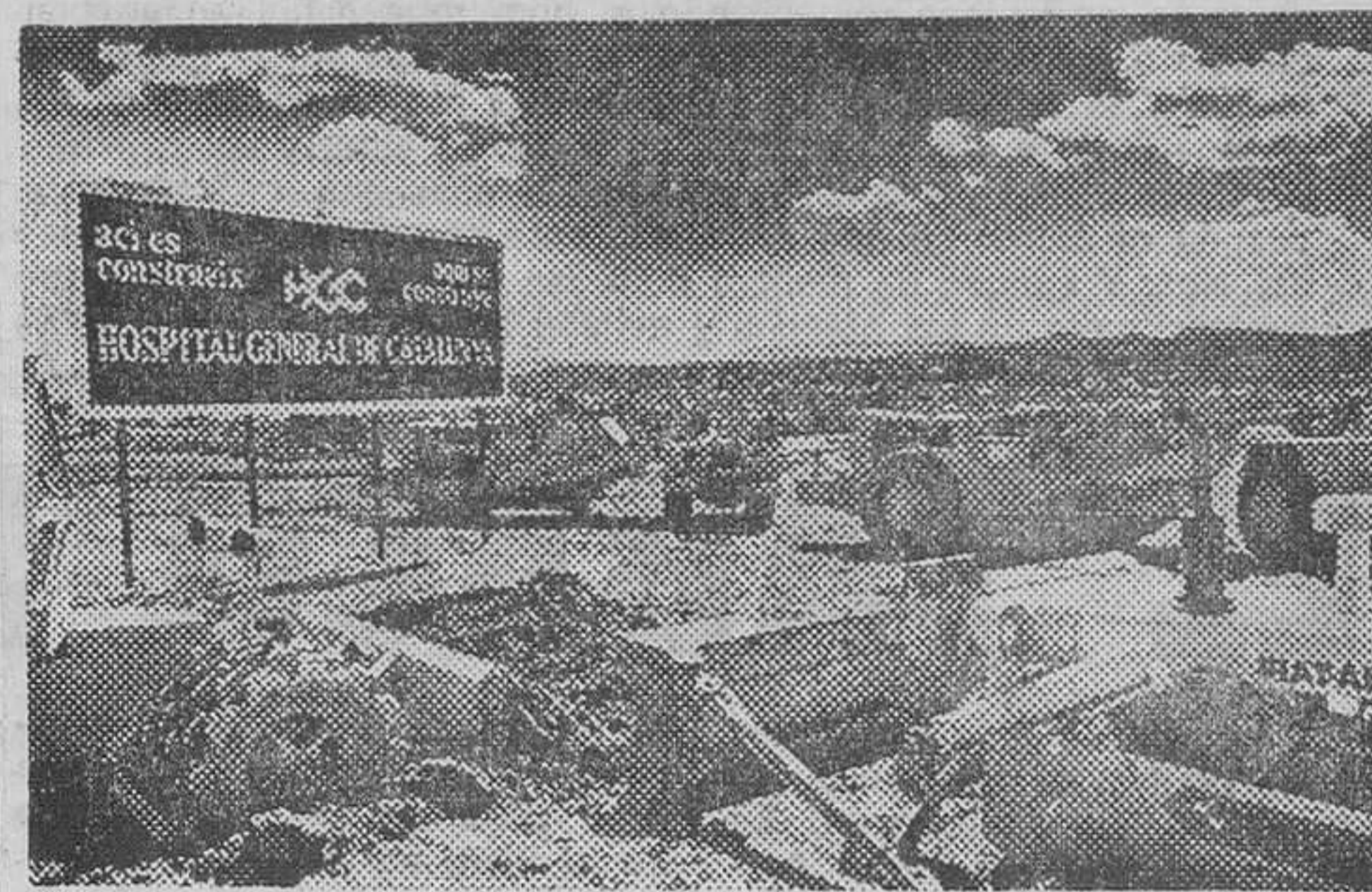
En los terrenos propiedad del Hospital General de Catalunya, en San Cugat del Vallès, se han iniciado el día 13 de marzo último las obras de Urbanización para la edificación del Hospital. La fotografía muestra un aspecto de los trabajos del movimiento de tierras
