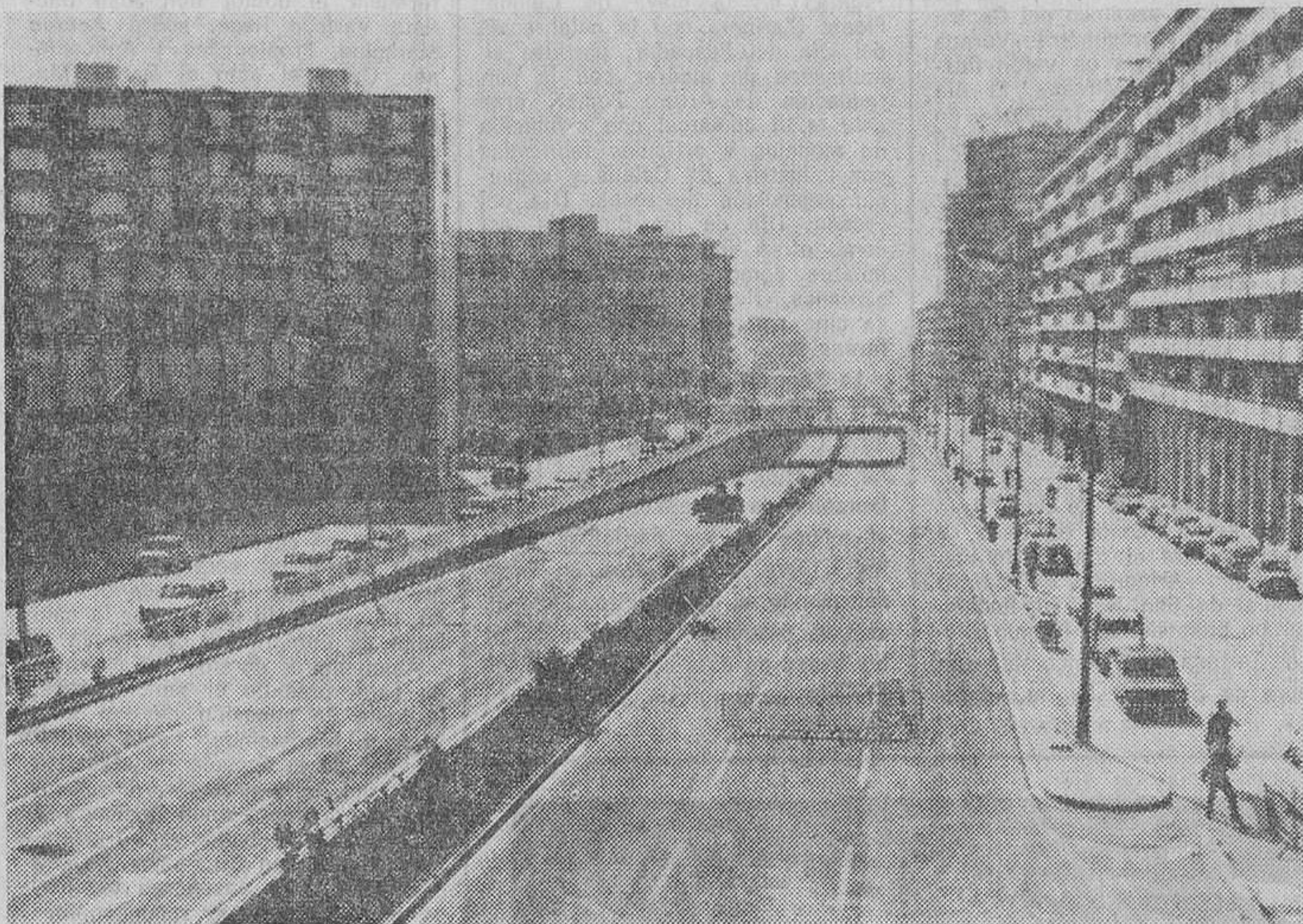
Aspecto parcial del primer tramo del I Cinturón de Ronda que entrará hoy en servicio, y que enlazará la plaza de Ildefonso Cerdá con la plaza de Espinosa de los Monteros. El tramo, de 3.570 metros de longitud, será inaugurado esta tarde por el alcalde, don José María de Porcioles. — (Foto Soterías.)
