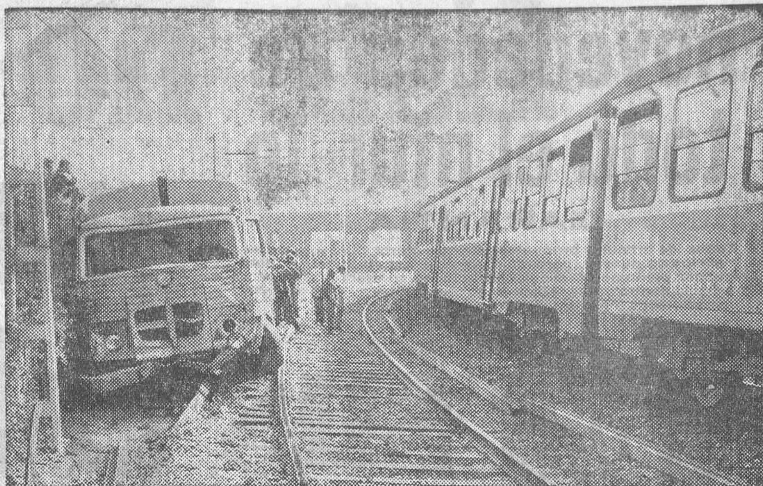
En el paso inferior de la plaza de las Glorias, un camión del servicio de recogida de basuras se salió de la calzada, yendo a caer sobre la vía del ferrocarril, que quedó momentáneamente interceptada, restableciéndose posteriormente el tráfico. Los dos ocupantes del vehículo siniestrado resultaron con heridas de gravedad. — (Foto Cifra)
